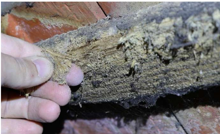
Obr. 19 Soli, ktoré sa vyplavujú zo škridiel výrazne vplývajú aj na stav latovania, ktoré je tiež vážne poškodené a na niektorých miestach je možné ho rozobrať prstami.
