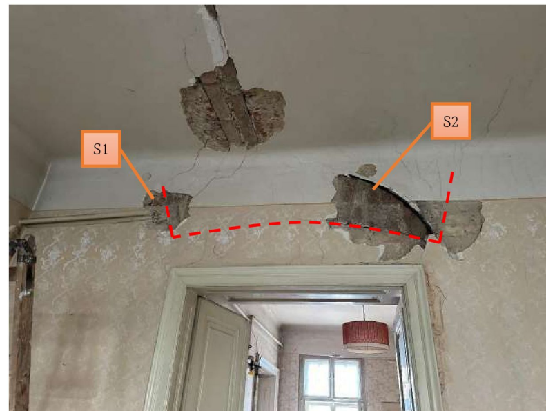
Obr. 32 Sondy nad dverným otvorom, čiarkovanou čiarou naznačená poloha klenbového pásu
