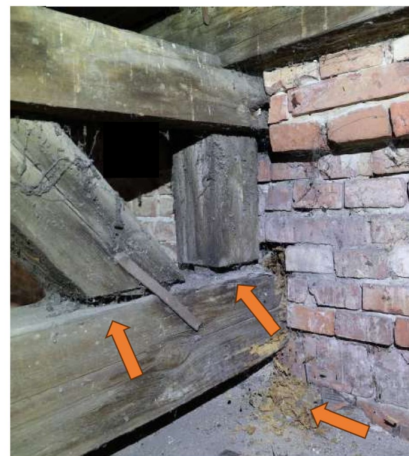
Obr. 7 Poškodené záhlavie väzného trámu. Väzný trám je poklesnutý a spoj stĺpika a väzného trámu je rozvoľnený. Šikmá vzpera už nepôsobí ako vzpera ale ako ťahlo. Normálové sily sa prenášajú do krokiev.
