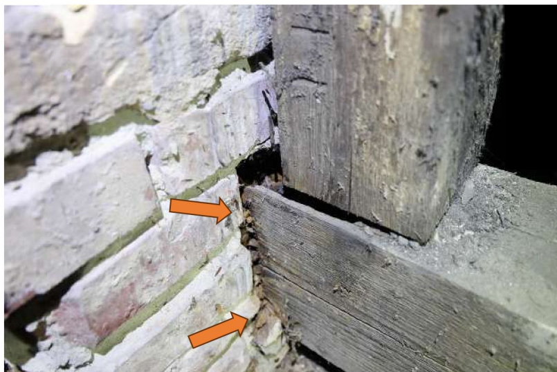
Obr. 4 Záhlavie väzného trámu viditeľne poklesnuté
