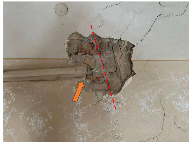
Obr. 33 Sonda S1. Detail prierezu pre plynové potrubie a zničená páta záklenku
