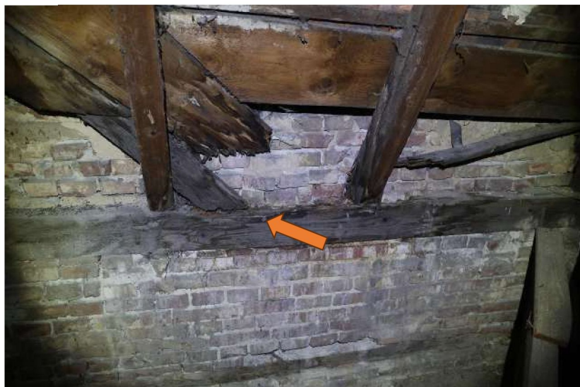
Obr. [redacted] Zatekaním poškodené osedlanie krokiev západného murovaného štítu
