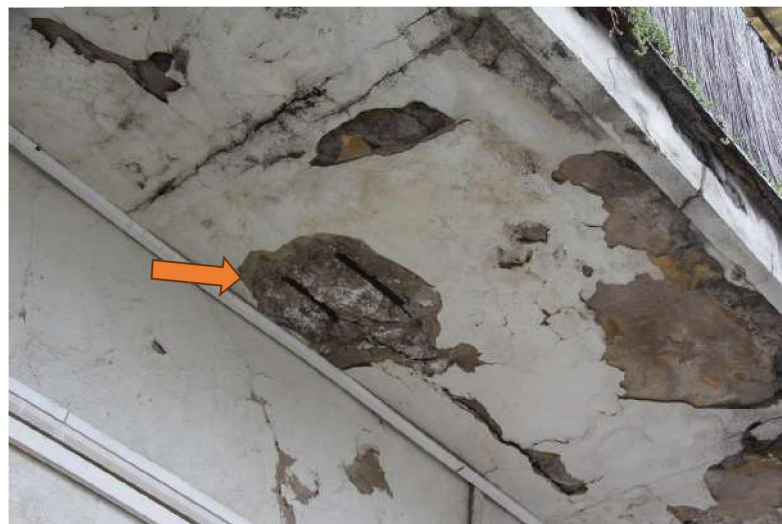
Obr. 25 2/2021 Segment pavlače a postupujúca korózia nosnej výstuže
