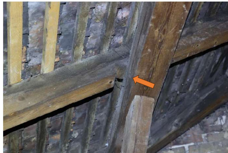
Obr. 10 Vytiahnuté osedlanie medzi väzbami č.26 a č.27 pravdepodobne spôsobené pohybom prahovej väznice do exteriéru
