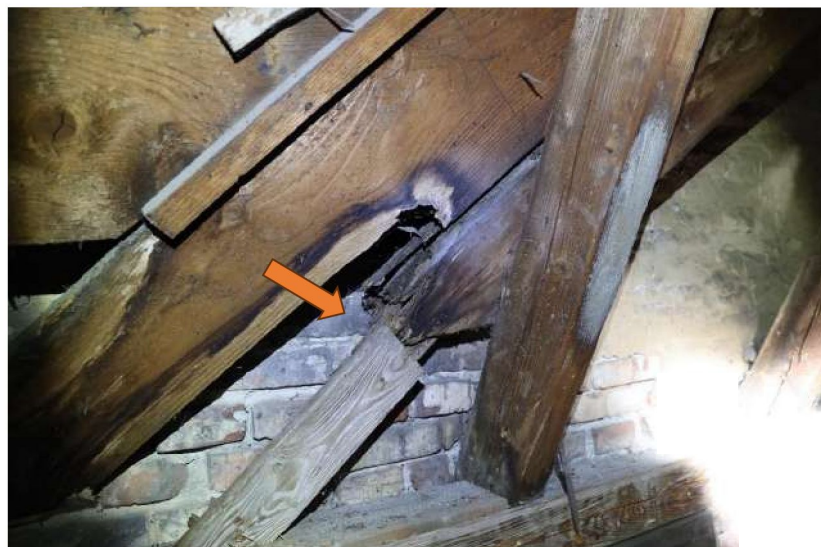
Obr. 12 Poškodené osedlanie krokiev západného štítu a pokus o opravu
