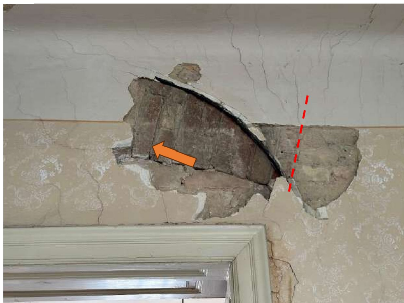
Obr. 34 Sonda S2. Otvárajúca sa trhlina na spodnej strane klenbového pásu ukazuje na posun v podperách
