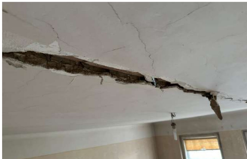
Obr. 30 [redacted] v miestnosti 305 a poklesnutý nosník
