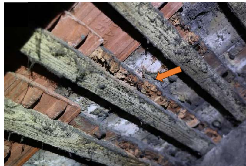
Obr. 13 Pôvodná a doplnená nová krytina. Pôvodná krytina je zvetraná a poškodená. Môže dôjsť ku vypadávaniu jednotlivých kusov krytiny. Strešné laty napadnuté hnilobou.
