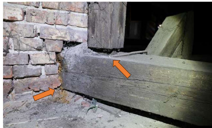
Obr. 6 Poškodené záhlavie väzného trámu. Väzný trám je poklesnutý a spoj stĺpika a väzného trámu je rozvoľnený.
