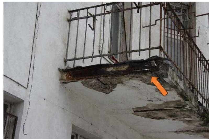
Obr. 23 2/2021 Krajný nosník pred statickým zabezpečením
