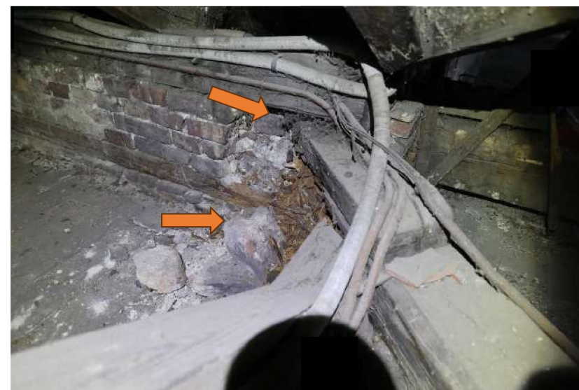
Obr. 3 Detail východného úžľabia, deštrukcia záhlavia trámov
