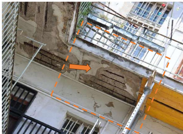
Obr. 26 6/2024 Segment pavlače v súčasnosti a úplne odkrytá výstuž so značnou koróziou
