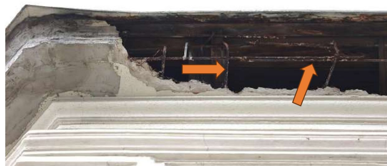
Obr. 37 Detail vypadnutej rímsy s viditeľnou výstužou
