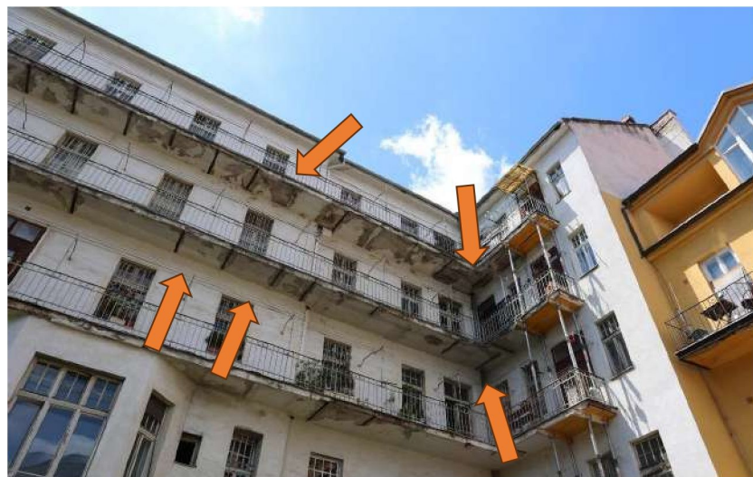
Obr. 22 6/2024 Korózia oceľových konzol a betonárskej výstuže sa rozšírila na ďalšie polia
