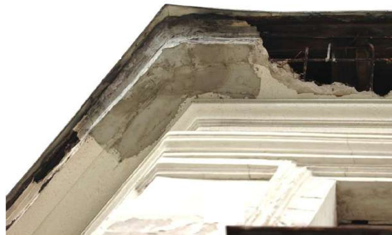
Obr. 36 Detail vypadnutej rímasy
