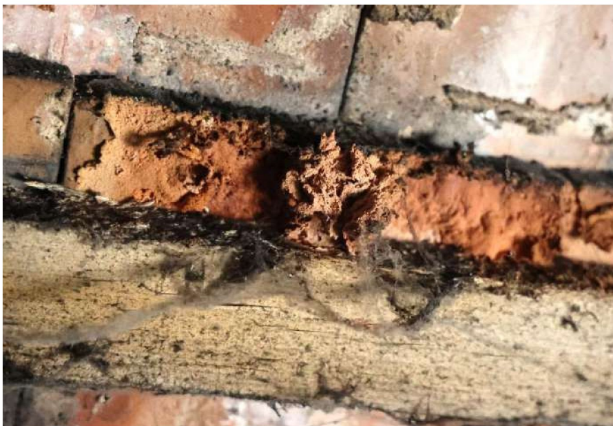
Obr. 18 Výrazne zdegradovaný materiál skridiel.
