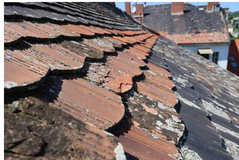
Obr. 16 Detail zvetranej krytiny s odpadávajúcimi časťami
