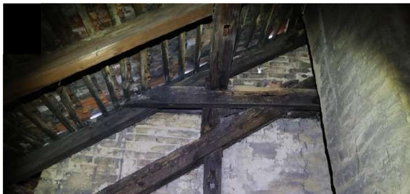
Obr. 9 Hnilobou napadnuté krokvy
