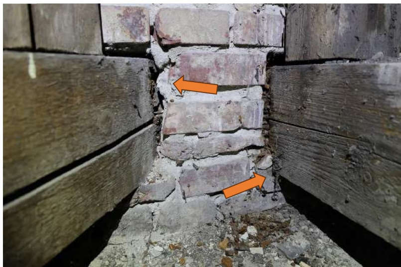
Obr. 5 Poškodené záhlavia väzných trámov. Väzný trám na pravej strane je viditeľne poklesnutý.
