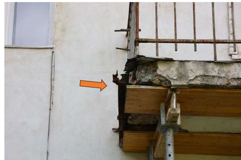
Obr. 24 6/2024 Krajný nosník v súčasnosti. Došlo k úplnému oddeleniu železobetónovej dosky od ocelevej konzoly. Doska v súčasnosti stojí len na dočasnom statickom zabezpečení.
