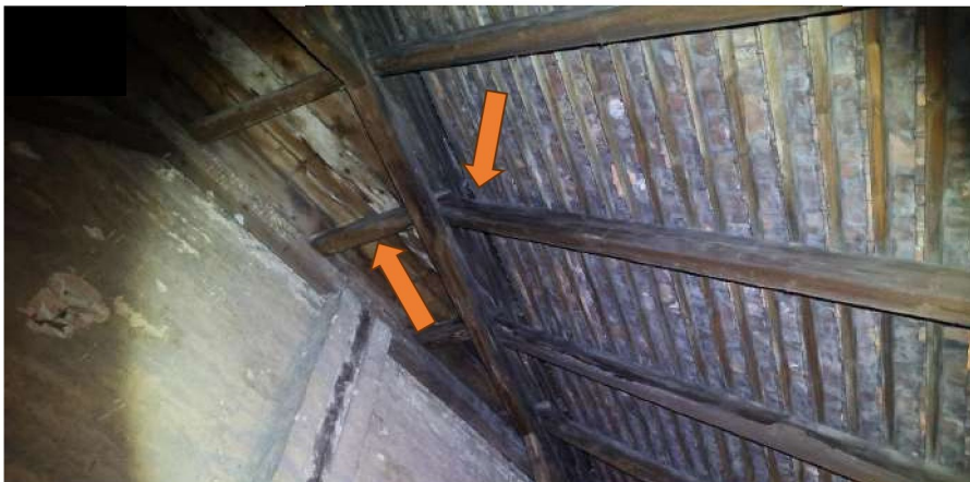
Obr. 8 Hnilobou napadnuté krokvy
