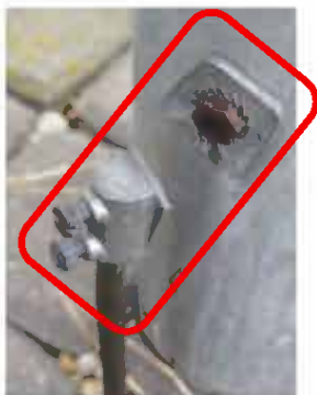
Obr. 7.16 Zlomené pripojenie uzemňovacieho vodiča k uzemňovacej svorke stožiara na Čárskeho ul.
