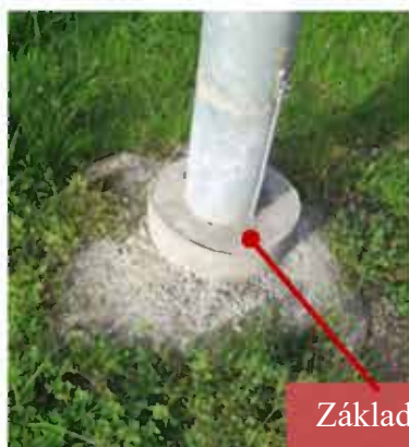
Obr. 7.8 Základové pätky pozinkovaných stožiarov
