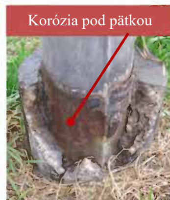
Obr. 7.8 Základové pätky pozinkovaných stožiarov
