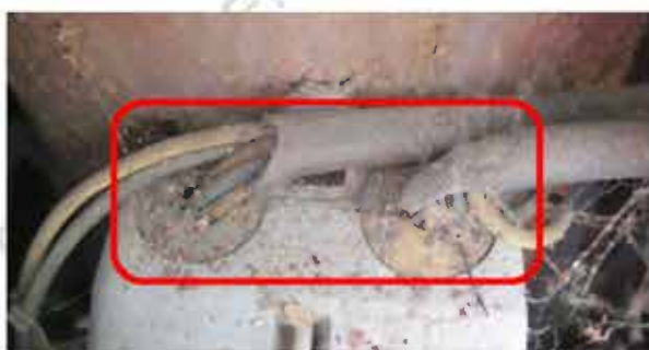
Obr. 7.14 Nevyhovujúce zaústenie vodičov dovnútra stožiarovej rozvodnice na Karloveskej ul.
