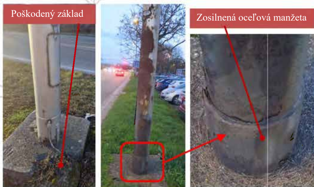
Obr. 7.6 Typické poškodenia cestných oceľových stožiarov starších typov
