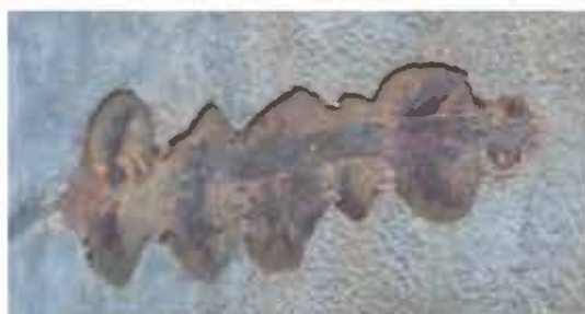
Obr. 7.9 Povrchová a prenikajúca korózia pozinkovaného stožiara typu RSV 85/A1500 (S051)
