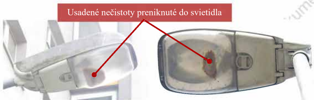
Obr. 7.4 Nečistoty usadené v optickej komore svietidla na Gallayovej ul. (vľavo) a Bagarovej ul. (vpravo) v dôsledku zníženia stupňa krytia IP
