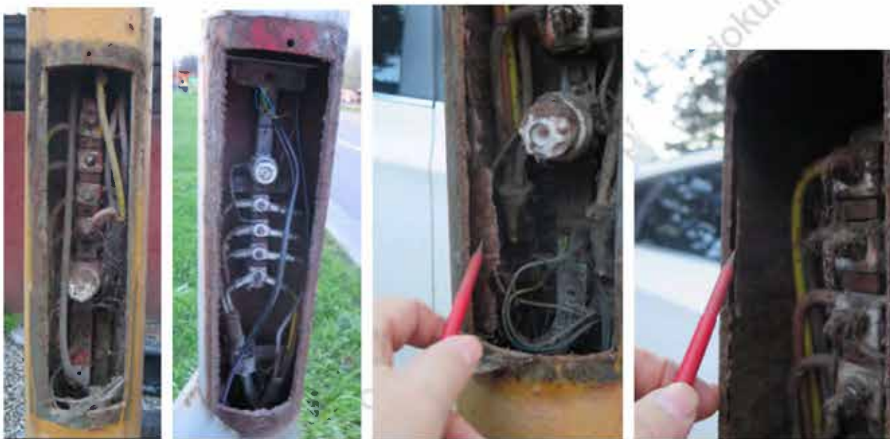
Obr. 7.17 Stožiarové svorkovnice starých typov Romo Fulnek na Blagoevovej a Dolnozemskej ul.
