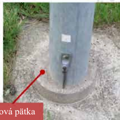
Obr. 7.8 Základové pätky pozinkovaných stožiarov
