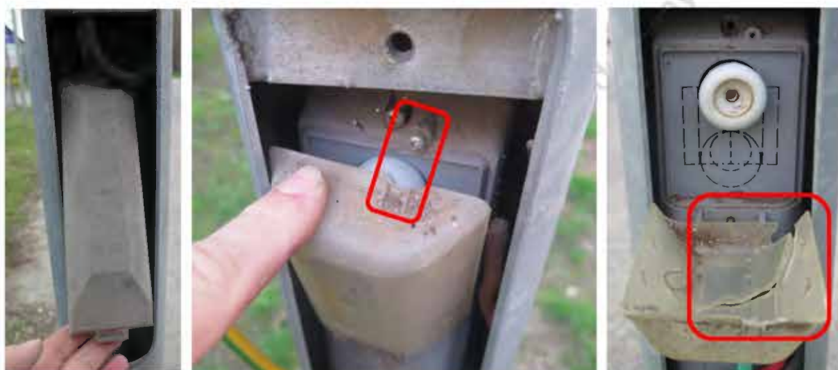
Obr. 7.13 Typický stav stožiarových rozvodníc – ulomené a rozbité časti krytu
