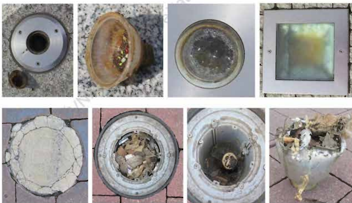
Obr. 7.5 Stav zemných svietidiel s charakteristickým zatečením (porušený stupeň krytia IP), mechanickým poškodením, rozbitým svetelným zdrojom až úplnou demontážou a zaslepením
