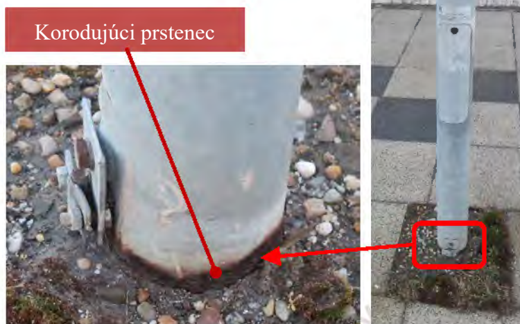
Obr. 7.10 Korodujúci prstenec v mieste votknutia stožiara typu Kovel 04 (S055) na Palmovej ul. – SM J008/020
