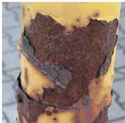
Obr. 7.7 Korózia ocelového stožiara v spodnej časti s elektrovýzbrojou na Palmovej ul.
