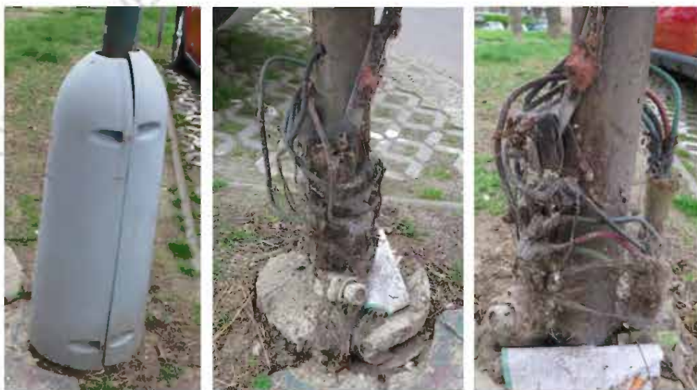
Obr. 7.19 Stav elektrovýzbroje v starých typoch päťcovaných ocelových stožiarov so samostatnými (nekompaktnými) svorkami a prístrojmi na Segnerovej ul. (SM K053/014)
