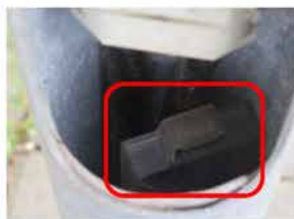
Obr. 7.15 Zapadnutý kryt stožiarovej rozvodnice na Čavojského ul.
