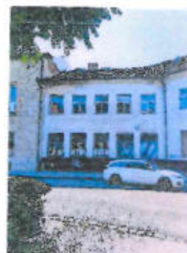
AB II. prístavba, Bazová ulica, pohľad od severu
