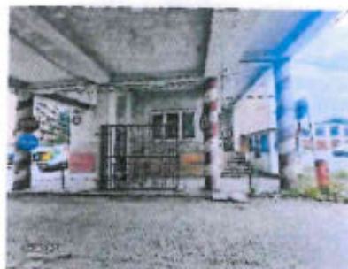
AB, podjazd, pohľad od severozápadu
