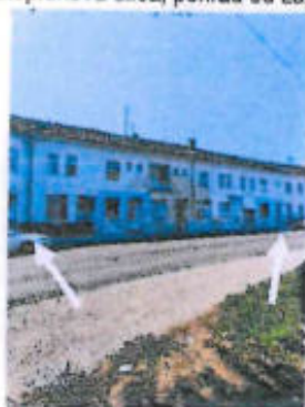
AB I. prístavba, Bazová ulica, pohľad od východu
