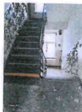
Schodisko z podesty na 1.NP
