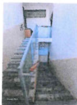
Schodisko z medzipodesty
