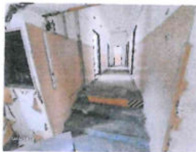
2.NP, chodba, vyrovnávacie schody do časti budovy nad podjazdom
