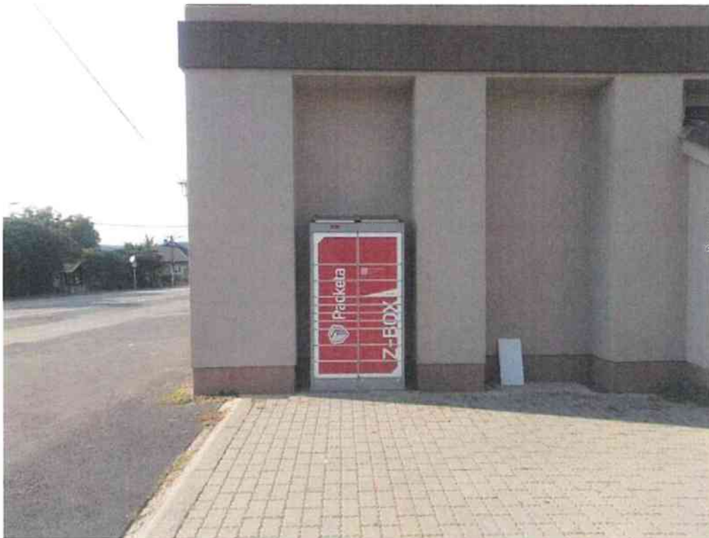
Príklad vhodného integrovania balikomatu do stávajúcej niky tak, aby nezavádzal. Situáciu by vylepšilo farebné prispôbenie k budove a jednoduchšie polepy. Zdroj: internet
