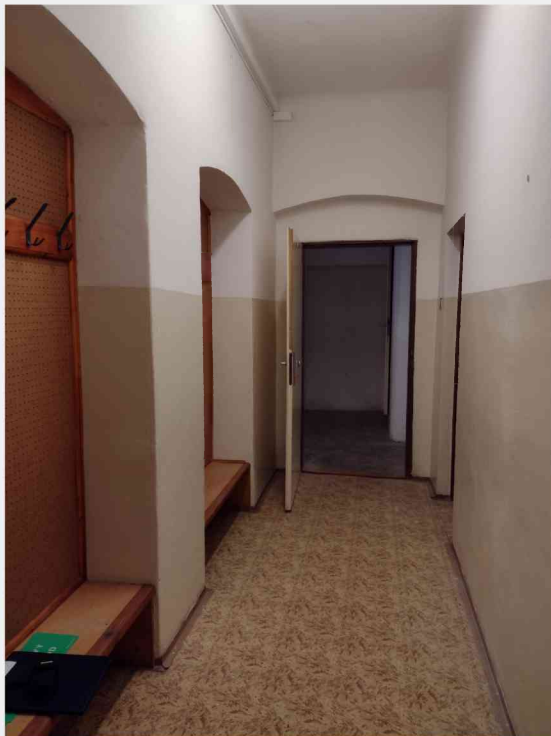
Rekonštrukcia interiéru- STAV PRED
