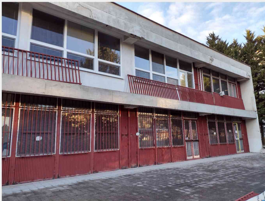
STAV PO (Tesne pred dokončením)
