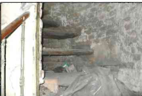
schodisko na povalu
