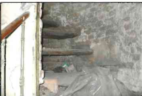
schodisko na povalu
