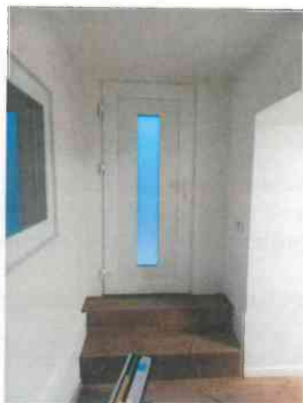
Byt č.2 na -1 suteréne
