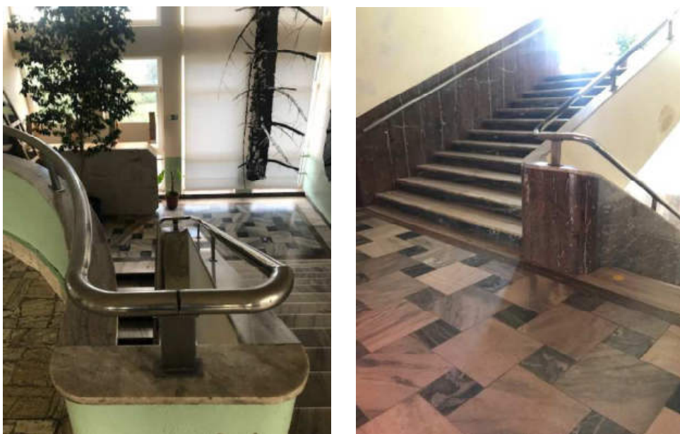
Pôvodné schodisko a dlažba
