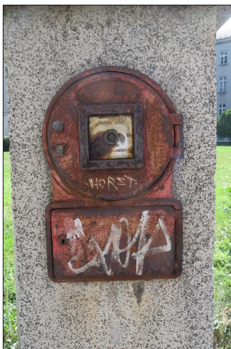
Dvierka s hlásičom a telefónom.
