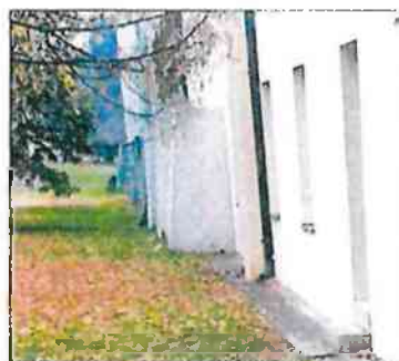
VYBÓRANIE EX. PILIERA A OPORNEJ STĚNY
