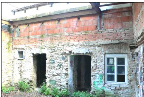
dvorná strana domu
