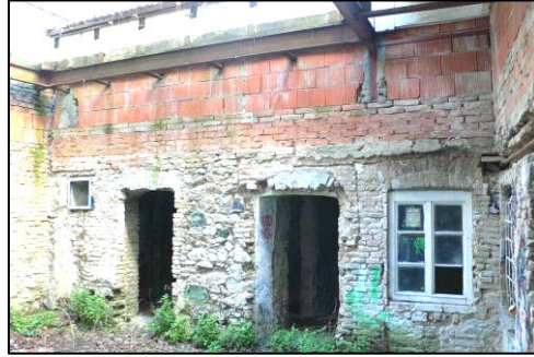
dvorná strana domu
