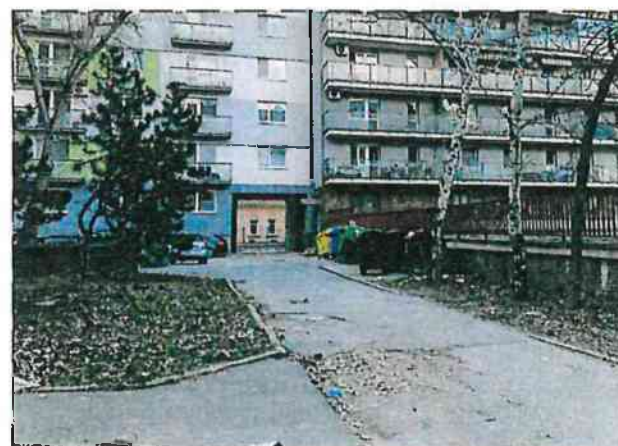
POHĽAD NA VJAZD
