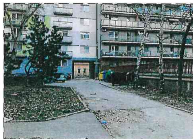
POHĽAD NA VJAZD
