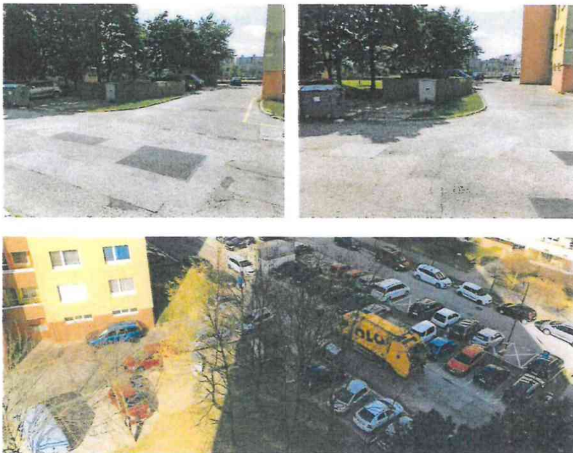
Obr.3,4, 5 – Aktuálny stav priestoru pre zámer vybudovania kontajnerového stojiska
