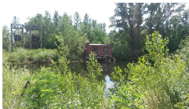
Nádrž hydrotechnického laboratória
