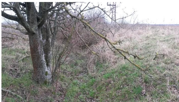
Odpadový kanál v Devínskej Novej Vsi – Hydromeliorácie
