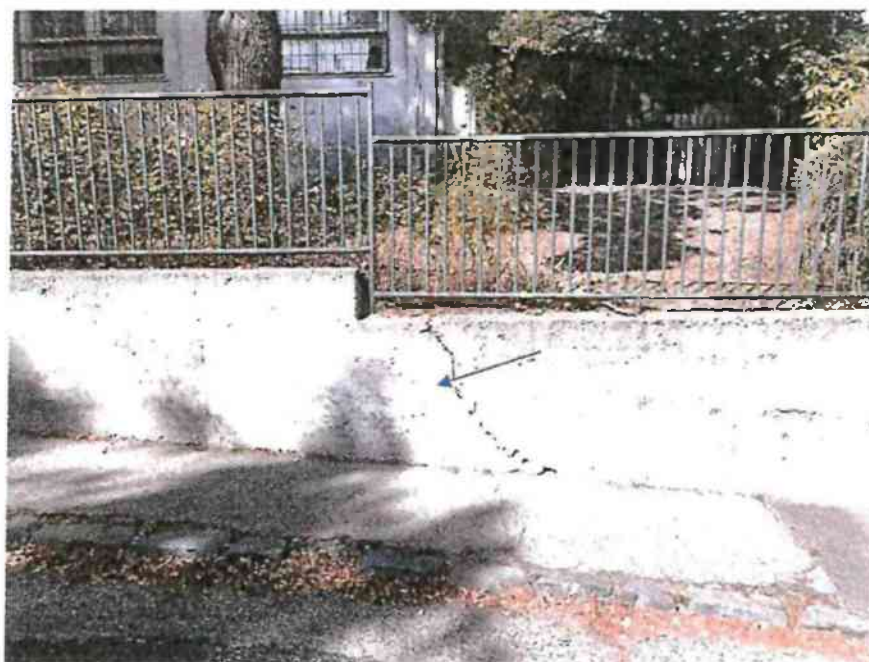
Obr.2 Ďalšia trhlinka o 3m vyššie
