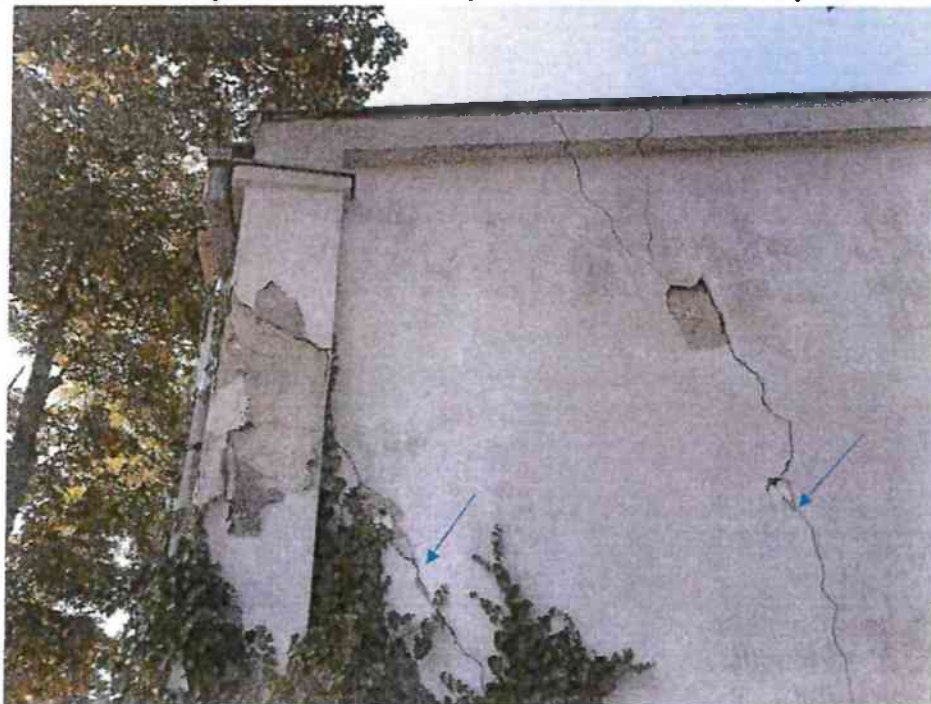
Obr.4 Trhlina na štítovej stene od Marhuľovej ulice, dôsledok sadania objektu
