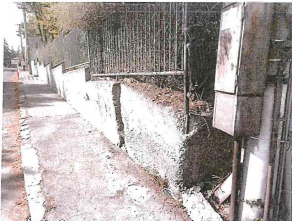
Obr.4 Trhlina na štítovej stene od Marhuľovej ulice, dôsledok sadania objektu
