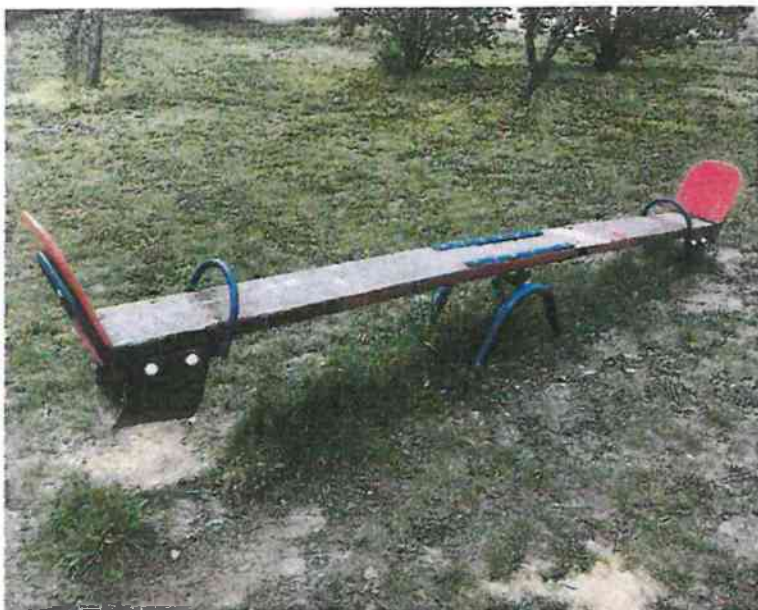
Kyvadlová hojdačka a klasická šmykľavka s prehnitými drevenými súčastami
