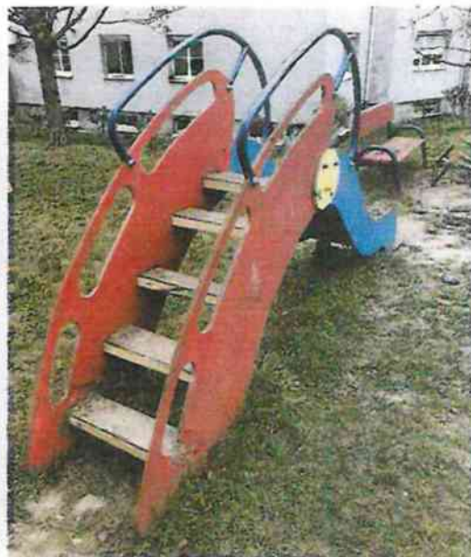
Kyvadlová hojdačka a klasická šmykľavka s prehnitými drevenými súčastami
