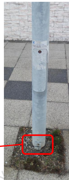
Obr. 7.10 Korodujúci prstenec v mieste votknutia stožiara typu Kovel 04 (S055) na Palmovej ul. – SM J008/020
