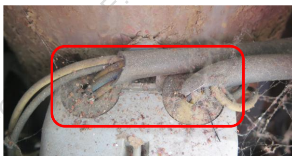
Obr. 7.14 Nevyhovujúce zaistenie vodičov dovnútra stožiarovej rozvodnice na Karloveskej ul.
