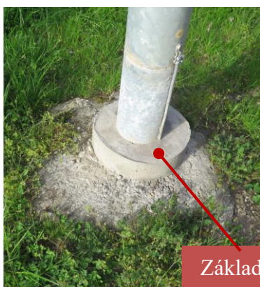
Obr. 7.8 Základové päťky pozinkovaných stožiarov
