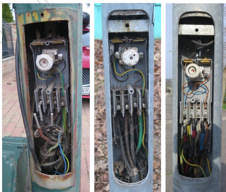
Obr. 7.11 Stožiarová rozvodnica bez vrchného krytu po ulomení pántov a/alebo záklapiek
