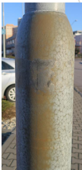
Obr. 7.9 Povrchová a prenikajúca korózia pozinkovaného stožiara typu RSV 85/A1500 (S051)
