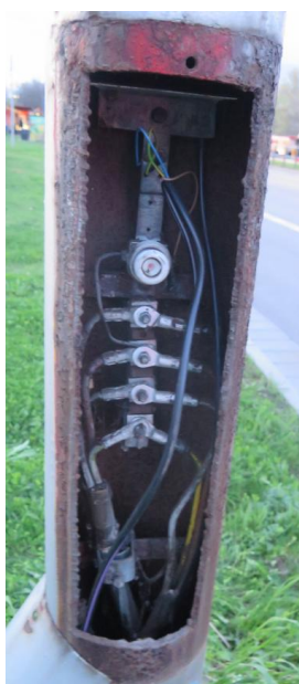
Obr. 7.17 Stožiarové svorkovnice starých typov Romo Fulnek na Blagoevovej a Dolnozemskej ul.
