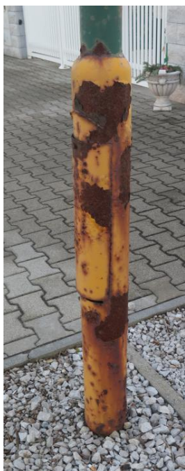
Obr. 7.7 Korózia ocelového stožiara v spodnej časti s elektrovýzbrojou na Palmovej ul.
