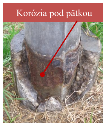
Obr. 7.8 Základové päťky pozinkovaných stožiarov
