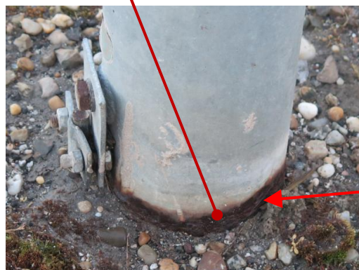
Obr. 7.10 Korodujúci prstenec v mieste votknutia stožiara typu Kovel 04 (S055) na Palmovej ul. – SM J008/020
