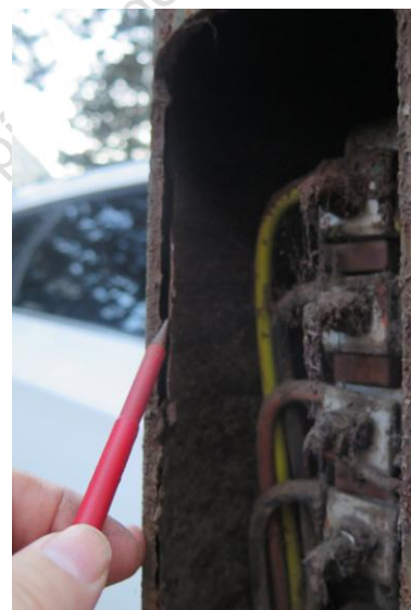
Obr. 7.18 Korózia vnútornej steny stožiaru odlupujúca sa po vrstvách na Blagoevovej ul.
