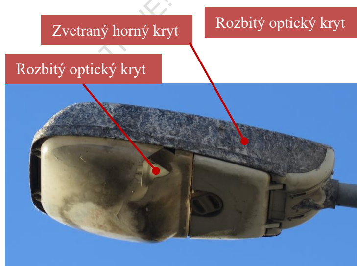
Obr. 7.2 Svietidlo typového radu SR 100 (L001-L005) na Kopčianskej ul. s rozbitým krytom optickej časti
