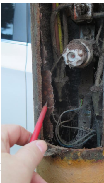
Obr. 7.18 Korózia vnútornej steny stožiaru odlupujúca sa po vrstvách na Blagoevovej ul.
