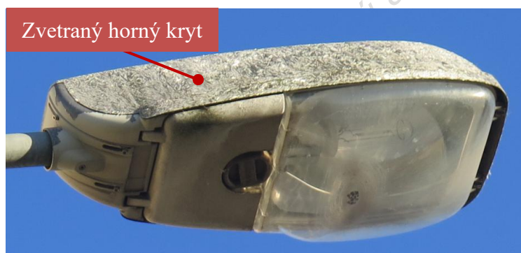
Obr. 7.1 Bežný stav svietidiel typového radu SR (L001-L005) na Kopčianskej ul.
