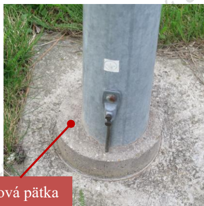
Obr. 7.8 Základové päťky pozinkovaných stožiarov
