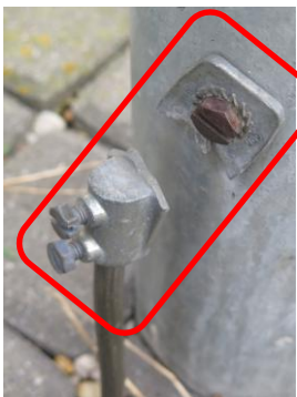
Obr. 7.16 Zlomené pripojenie uzemňovacieho vodiča k uzemňovacej svorke stožiaru na Čárskeho ul.
