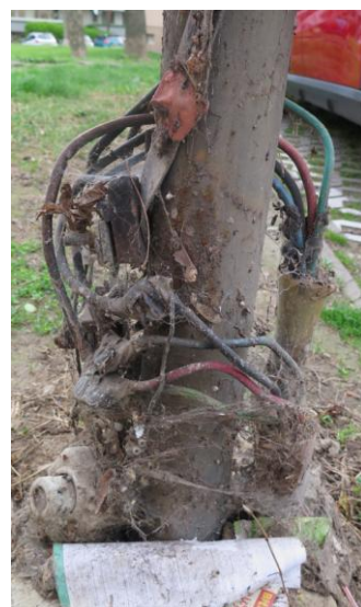
Obr. 7.19 Stav elektrovýzbroje v starých typoch päťcovaných ocelových stožiarov so samostatnými (nekompaktnými) svorkami a prístrojmi na Segnerovej ul. (SM K053/014)
