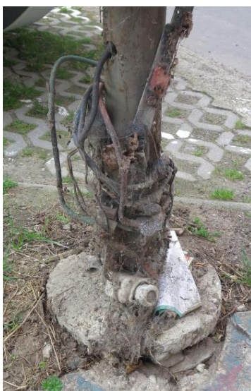
Obr. 7.19 Stav elektrovýzbroje v starých typoch päťcovaných ocelových stožiarov so samostatnými (nekompaktnými) svorkami a prístrojmi na Segnerovej ul. (SM K053/014)
