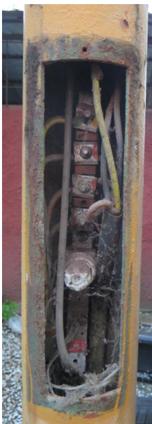
Obr. 7.17 Stožiarové svorkovnice starých typov Romo Fulnek na Blagoevovej a Dolnozemskej ul.
