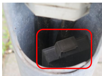
Obr. 7.15 Zapadnutý kryt stožiarovej rozvodnice na Čavojského ul.
