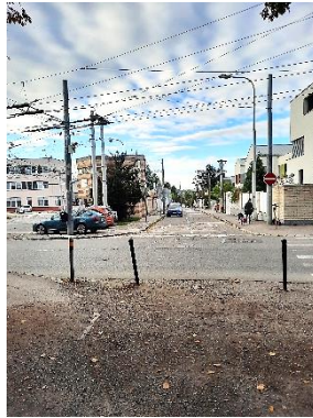
Okolie pozemkov areálu Vozovne DPB na Bohúňovej ulici, pohľad od JV cez Hroboňovu ulicu
