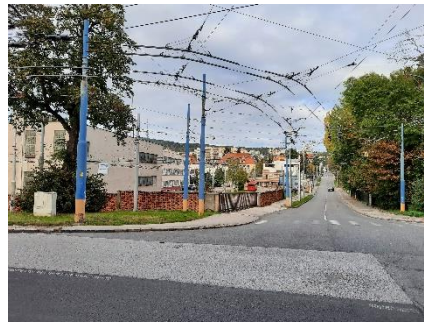
Hranica pozemku parc. č. , pozdĺž Hroboňovej ulice, pohľad od JZ
