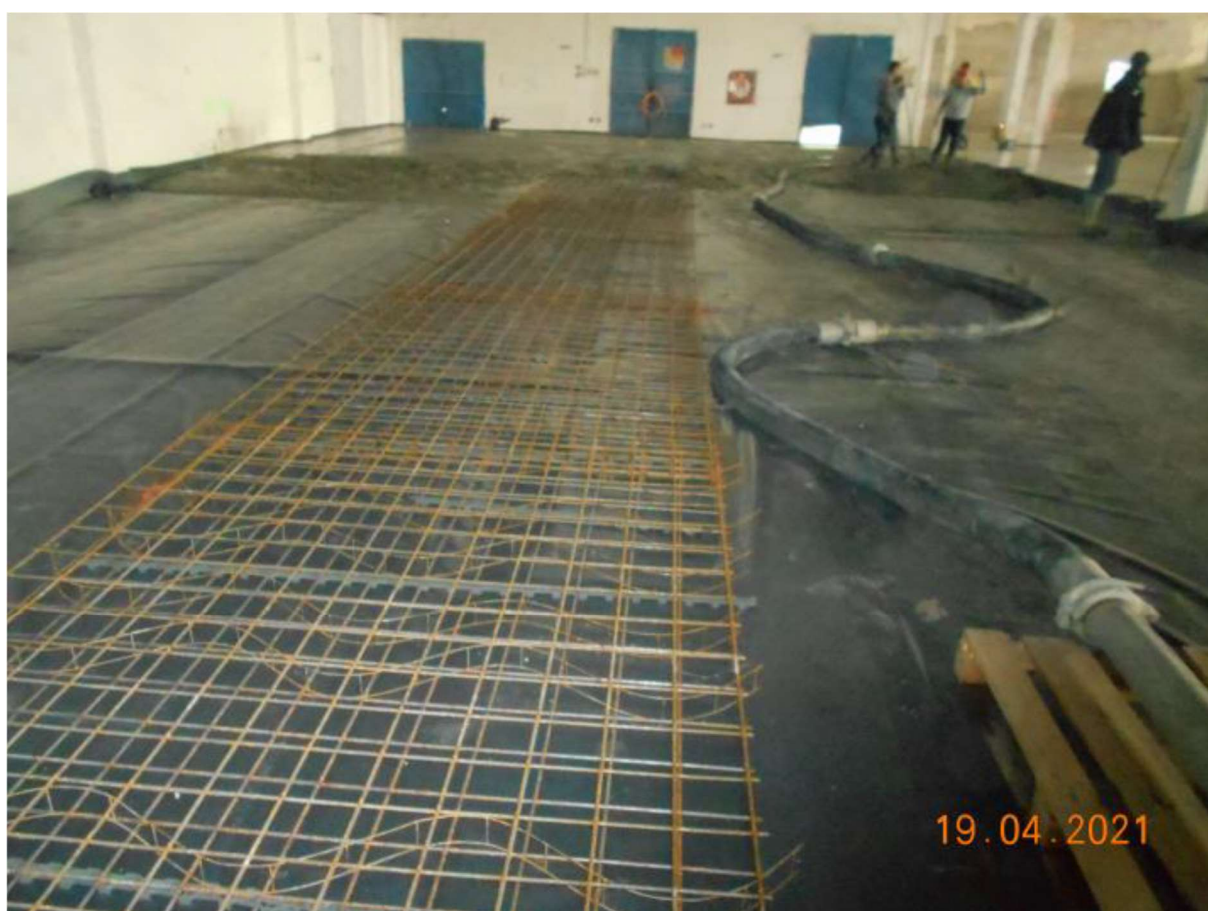
Práce na rekonstrukcií hál na depozitár
