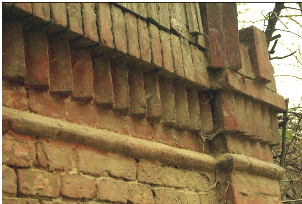
Detail tehlového muriva pivnice
