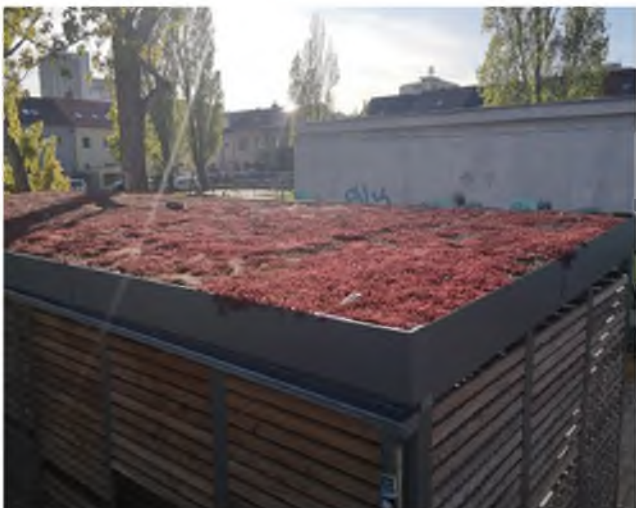
kontajnerové stanovište s extenzívnou vegetačnou strechou Ľudové námestie, Bratislava
