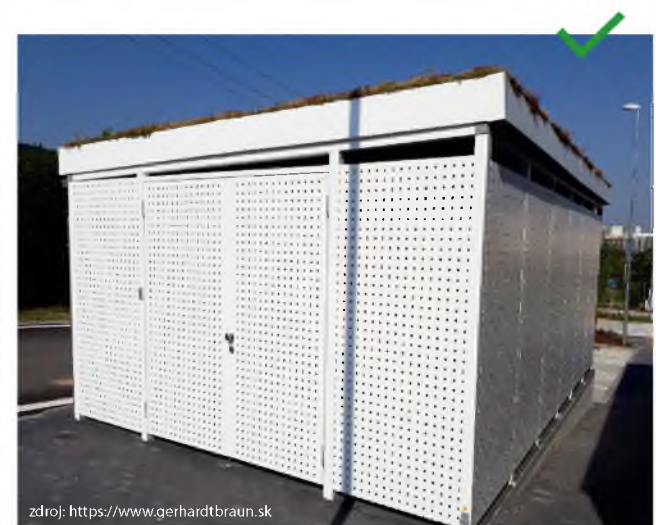
kontajnerové stanovište s extenzívnou vegetačnou strechou Eisnerova ulica, BD Devínka
