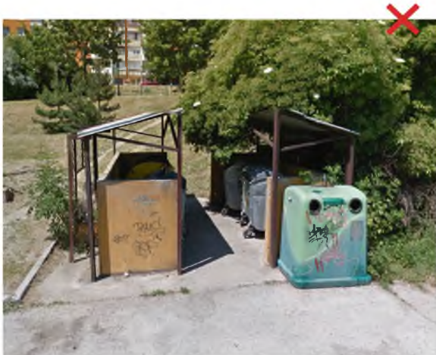
kontajnerové stanovište vyžadujúce rekonštrukciu Tománkova ulica
