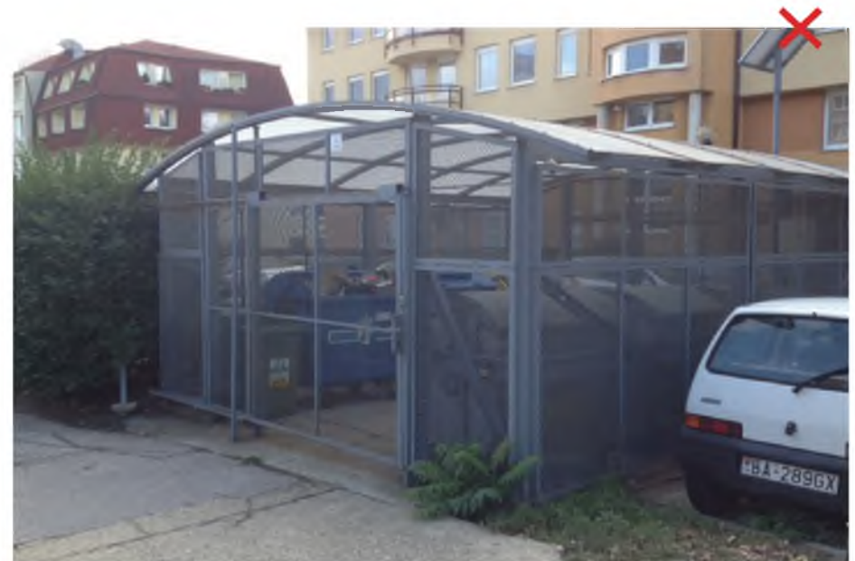
steny kontajnerového stanovišta by mali byť min. do výšky 1,5 m nepriehľadné Ulica Hany Meličkovej
