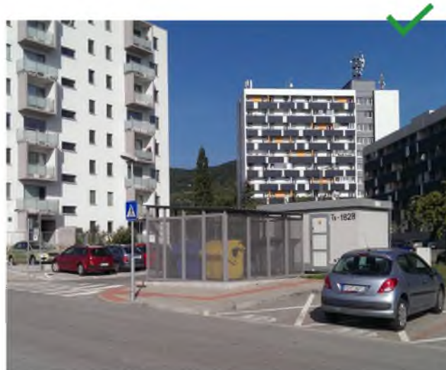
kontajnerové stanovište je vybudované na existujúcej spevnenej ploche Jurská ulica
