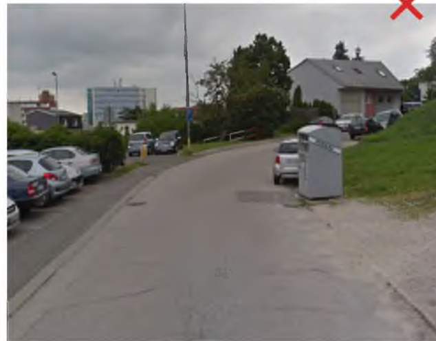
nádoba na textil na chodníku a v zákrute zneprehľadňuje premávku, kontajnery nesmú byť bariérou na komunikáciách (cesty, chodníky) Klenova ulica
