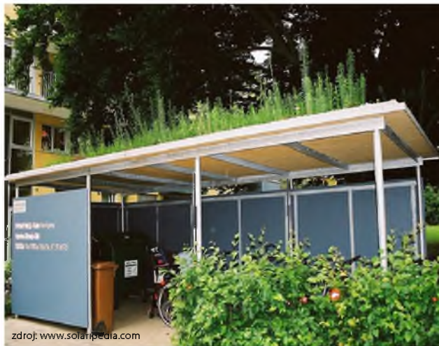
prístrešok na smetné nádoby a bicykle s vegetačnou strechou Friebourg, Nemecko
