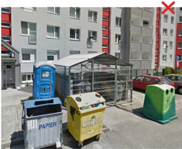
nedostatočná kvalita architektonicko - estetického riešenia, nevyhovujúca veľkosť stanovišťa, nevhodné umiestnenie stanovišťa Ulica Ľ. Fullu
