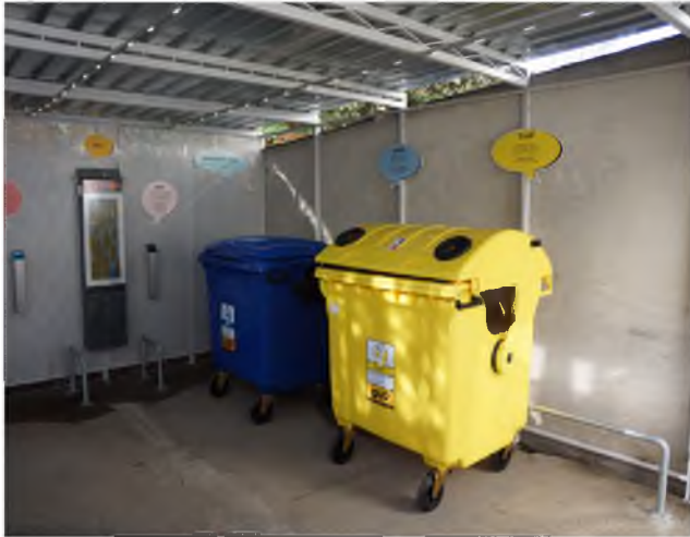
kontajnerové stanovište je okrem smetných nádob vybavené aj osvetlením, informačnými tabuľkami v tvare bublín a ochrannými kovovými zábranami pri stenách a olejčke (pokiaľ má olejčka horizontálny tvar zábrany netreba)
