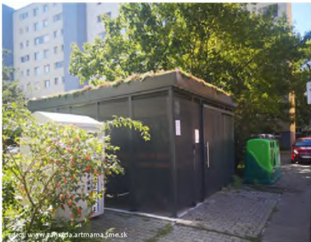
kontajnerové stanovište s extenzívnou vegetačnou strechou Ulica Budyšínska / Tehelná, Bratislava
