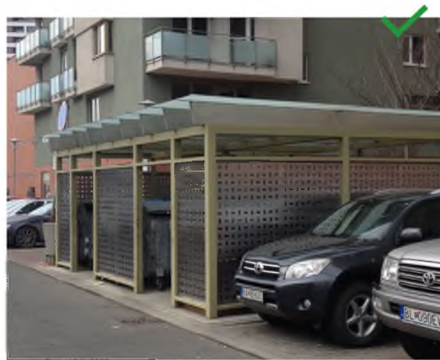
kontajnerové stanovište je farebne zladené s bytovým domom a skonštruované z kvalitných materiálov Bosákova ulica
