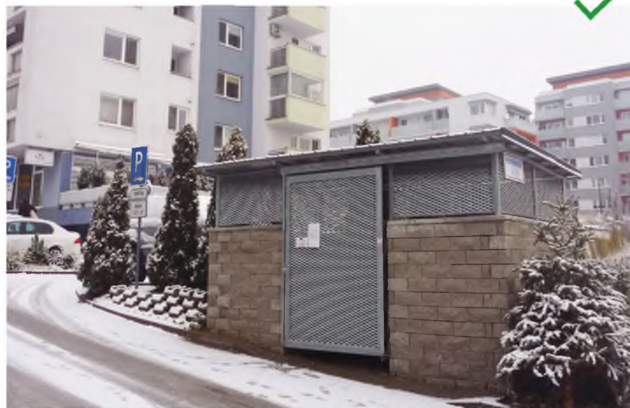
kontajnerové stanovištie je umiestnené pri komunikácii v dostatočnej vzdialenosti od bytového domu Kadnárova ulica
