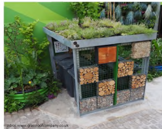
prístrešok na smetné nádoby s vegetačnou extenzívnou strechou a hmyzím hotelom Essex, Veľká Británia
