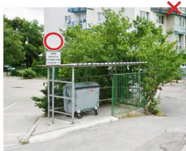
nedostatočná kvalita architektonicko- estetického riešenia, nevyhovujúca veľkosť kontajnerového stanovišťa Hečkova ulica
