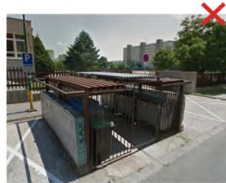
nepriaznivý stav kontajnerových stanovišť Rajčianska a Jégeho ulica
