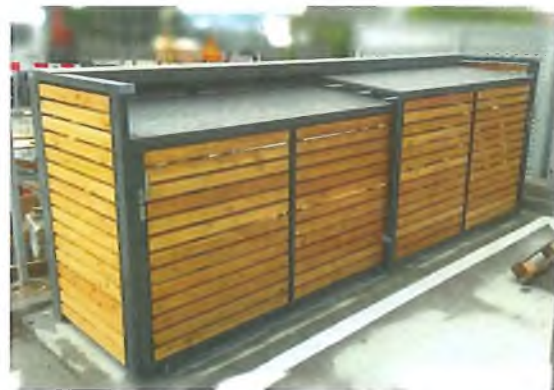
Príklad realizovaného kontajnerového boxu – Drotárska cesta, BA
