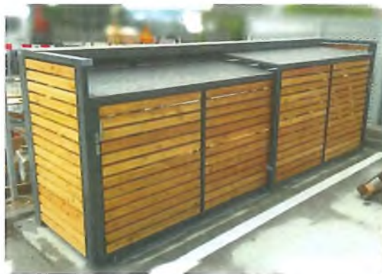
Príklad realizovaného kontajnerového boxu – Drotárska cesta, BA
