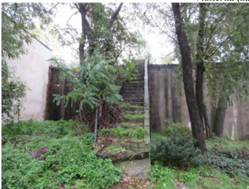
Viditeľná (nadzemná) časť vodojemu
