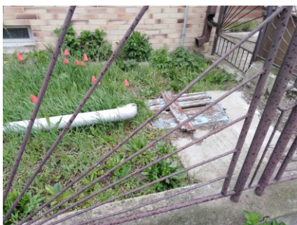
Vodomerná šachta na pozemku p.č. 518/5
