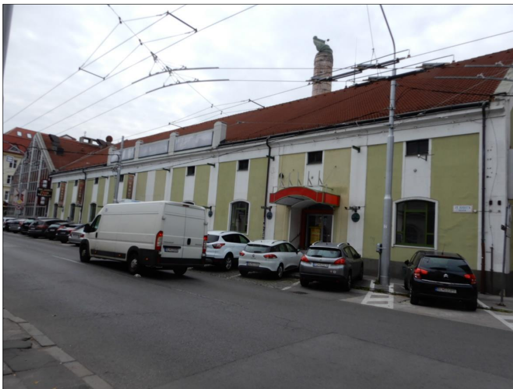
Uličná fasáda, Ul. 29. augusta
