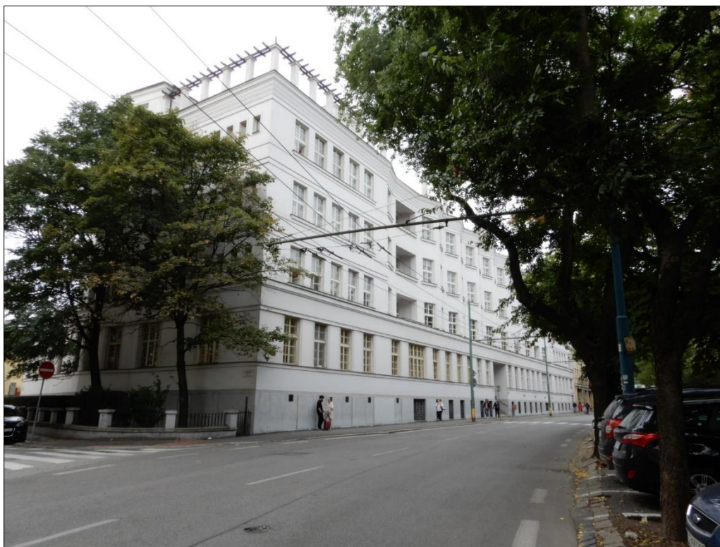
Uličná fasáda, Ul. 29. augusta
