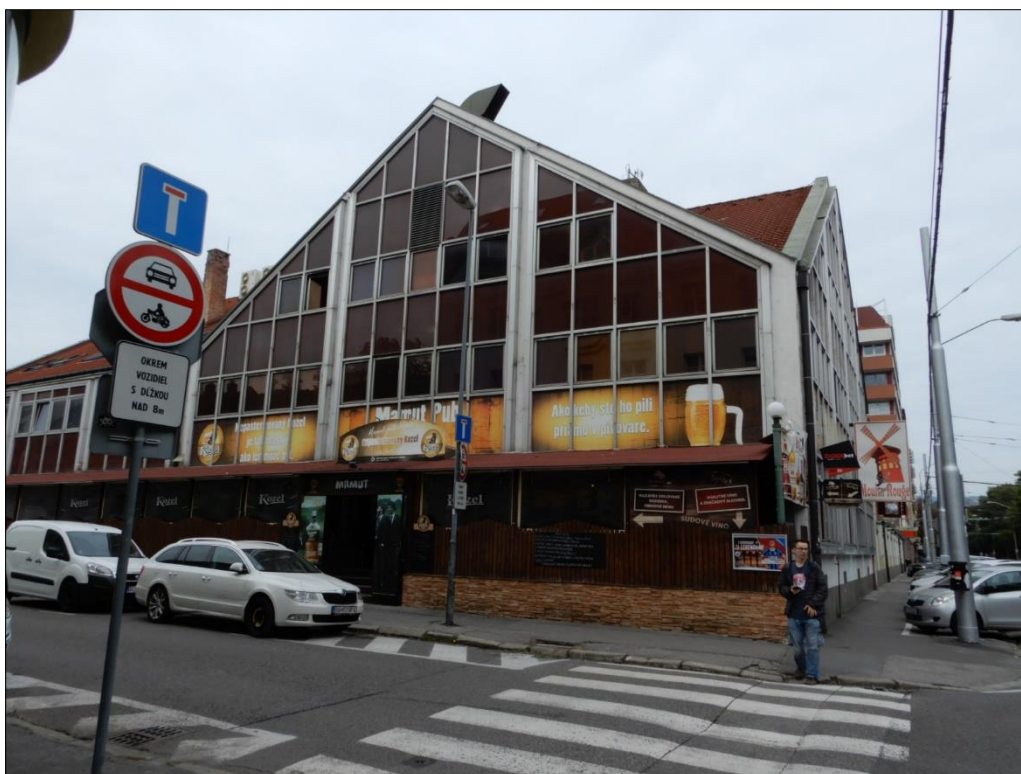
Uličná fasáda, Ferienčíkova ul., prístavba z roku 1975
