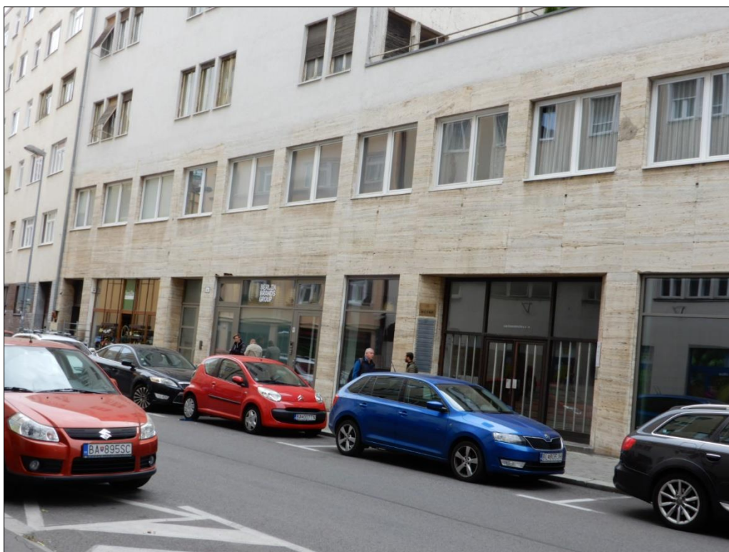
Uličná fasáda, obklad travertínom
