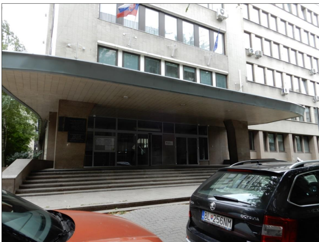
Hlavný vstup, Dobrovičova ul. č. 12
