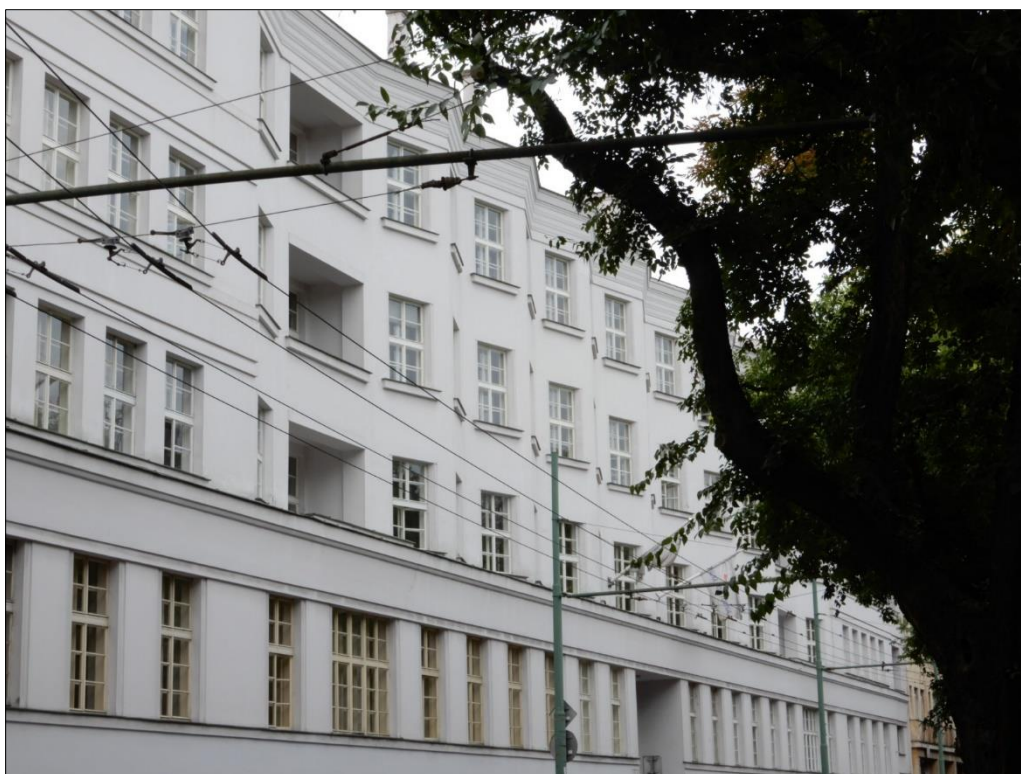
Uličná fasáda, detail priečelia
