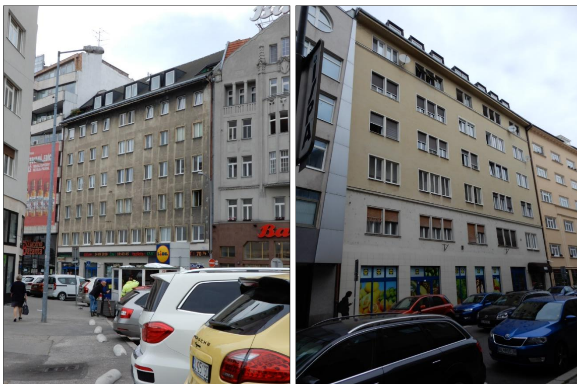
Uličná fasáda Dunajská a Grösslingova ulica
