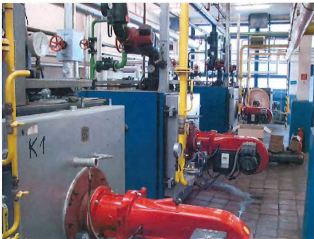
Pohľad na nízkotepelné kotle s pretlakovými horákmi v kaskáde
