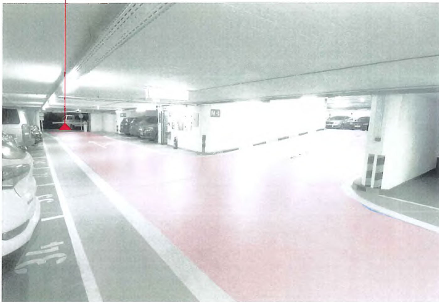
Vjazd do podzemnej garáže magistrátu -1 a -2
