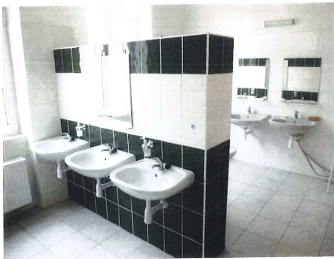
3. realizovaná rekonštrukcia interiérov - hygienická časť
