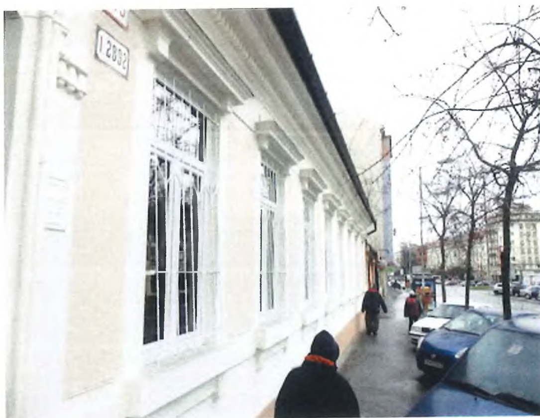
1. realizovaná rekonštrukcia fasády
