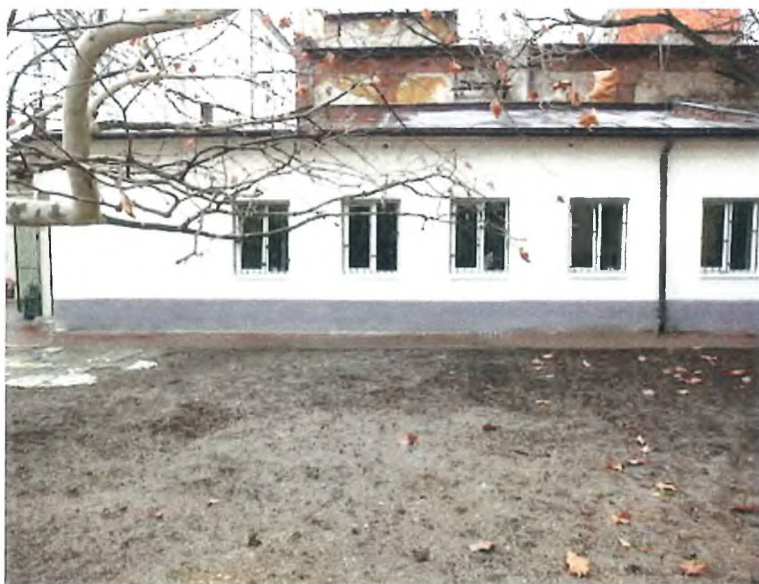
2. realizovaná rekonštrukcia budovy jedálne
