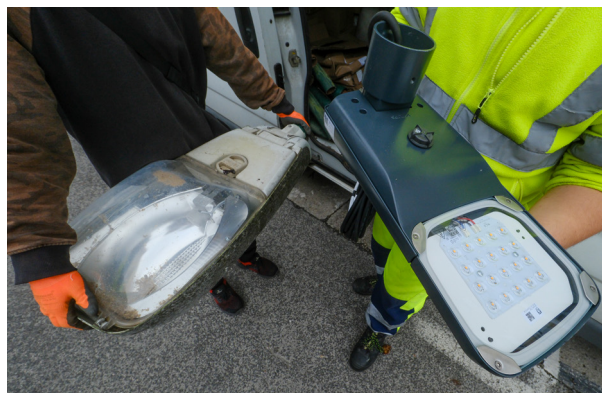
Modernizácia verejného osvetlenia, výmena za nové LED svietidlá
