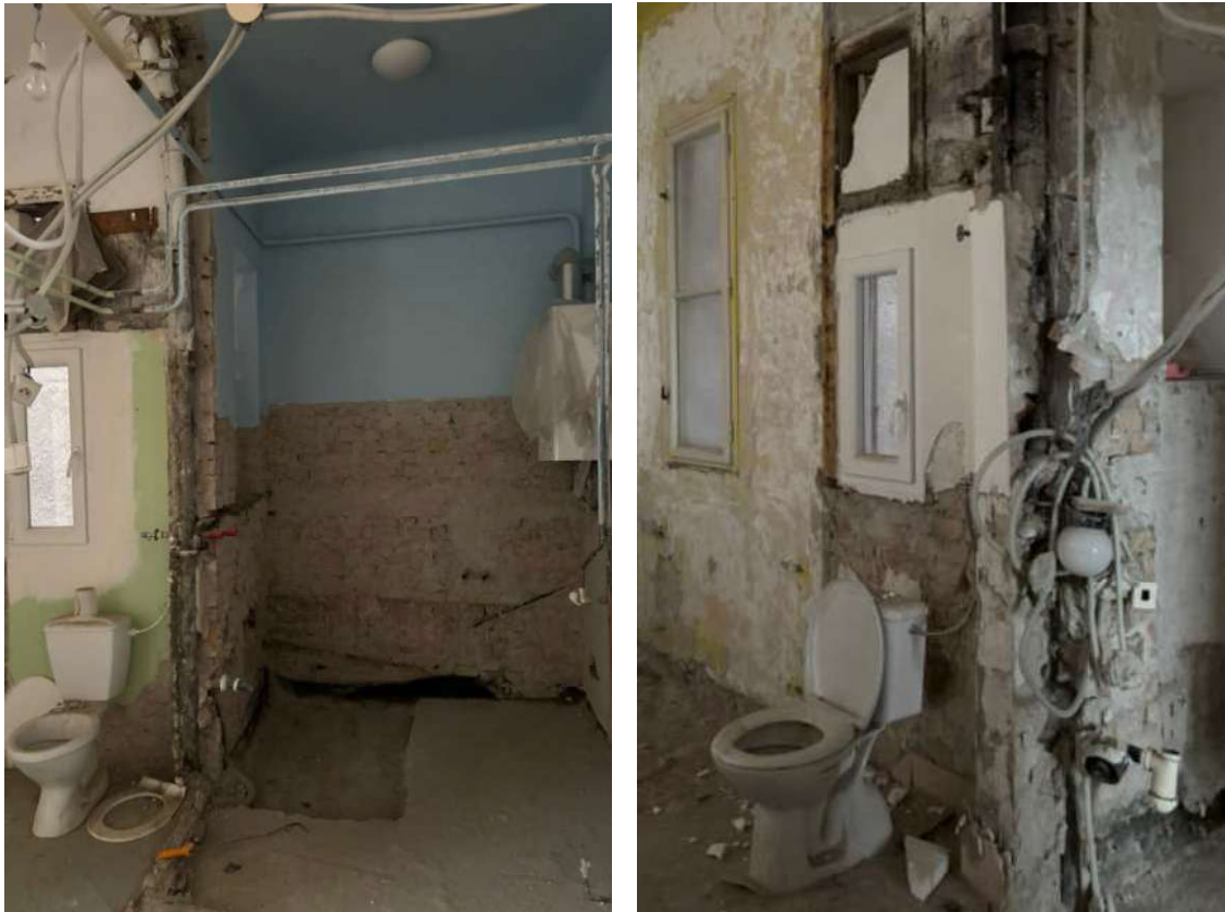
Obr.č. 9, 10 – Súčasný stav sociálnych zariadení
