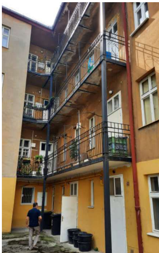
Obr.č. 25, 26 – podperné ocelové stojky pavlačí a nefunkčné kotvenie zábradlia
