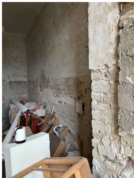
Obr.č. 4, 5 – Poškodené steny suterénnych priestorov
