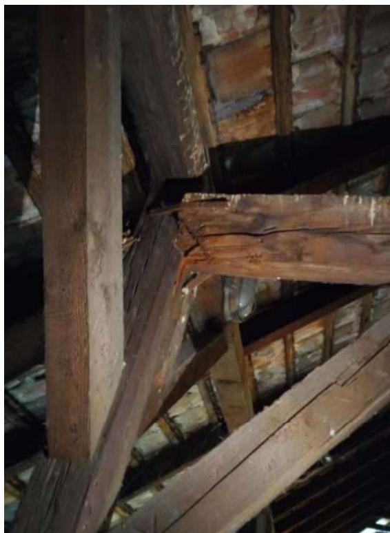
Obr.č. 21, 22 – nefunkčné uvoľnené detaily stykov nosných prvkov
