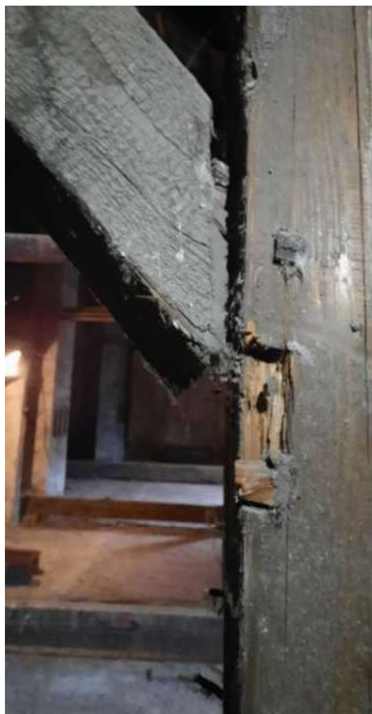
Obr.č. 21, 22 – nefunkčné uvoľnené detaily stykov nosných prvkov
