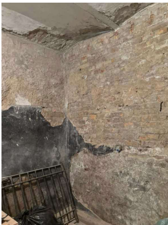
Obr.č. 6, 7 – Obnažené murivo štítového muriva – práčovňa
