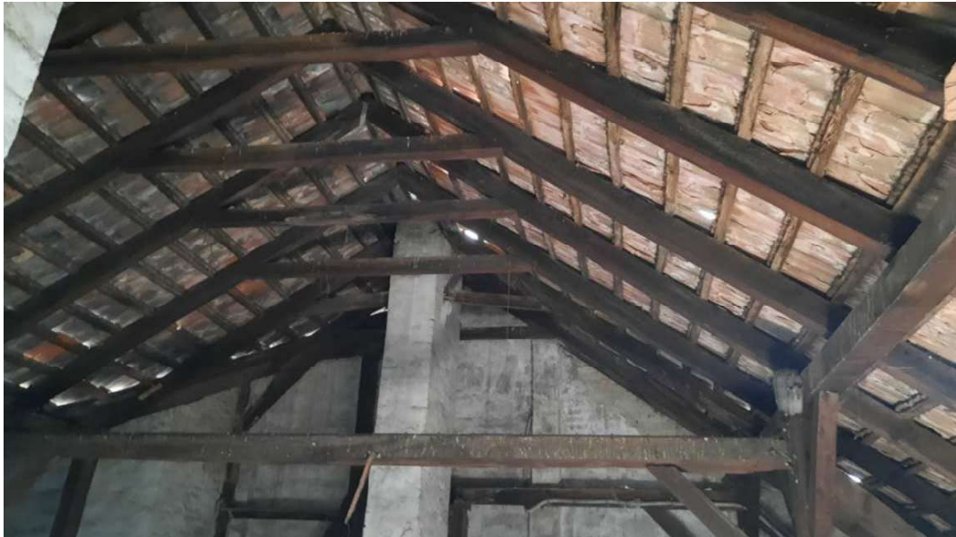
Obr.č.16 – sedlový krov – stužujúci trám stolice
