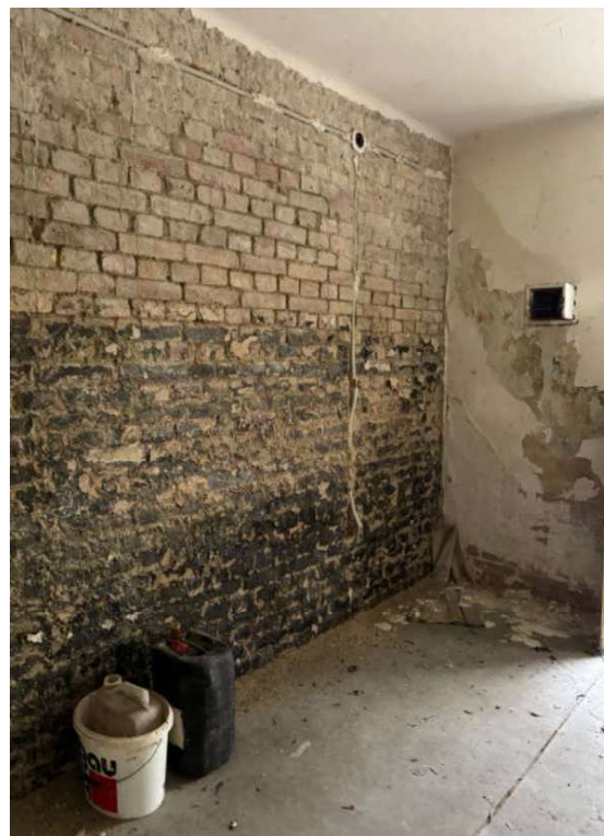
Obr.č. 6, 7 – Obnažené murivo štítového muriva – práčovňa
