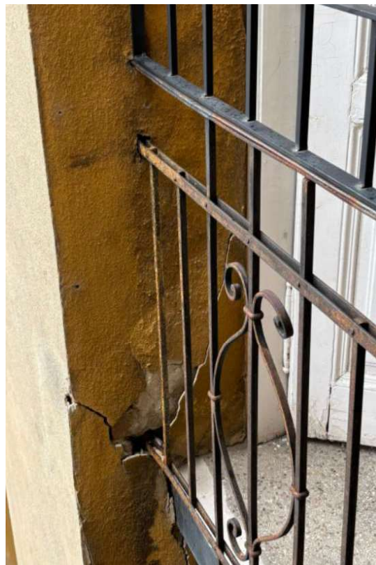
Obr.č. 25, 26 – podperné ocelové stojky pavlačí a nefunkčné kotvenie zábradlia
