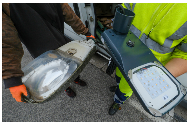
Modernizácia verejného osvetlenia, výmena za nové LED svietidlá
