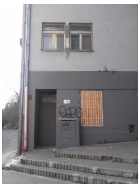
Vstup do objektu
