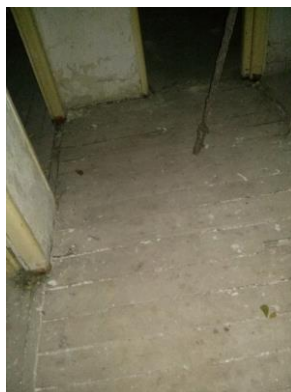
Chodba, pohľad od vstupu
