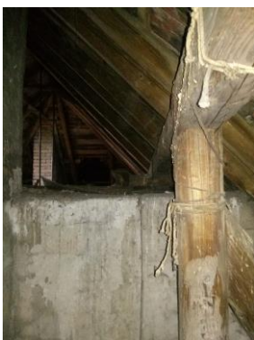
Zastrešenie, krovová konštrukcia
