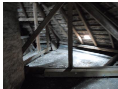
Zastrešenie, krovová konštrukcia
