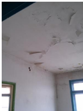
Detail strop v kizbe
