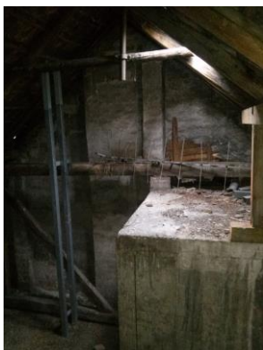
Pohľad zo stropu nad bytom
