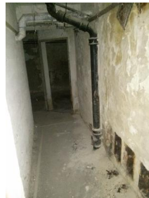
Chodba do skladov
