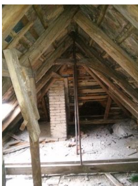
Zastrešenie, krovová konštrukcia
