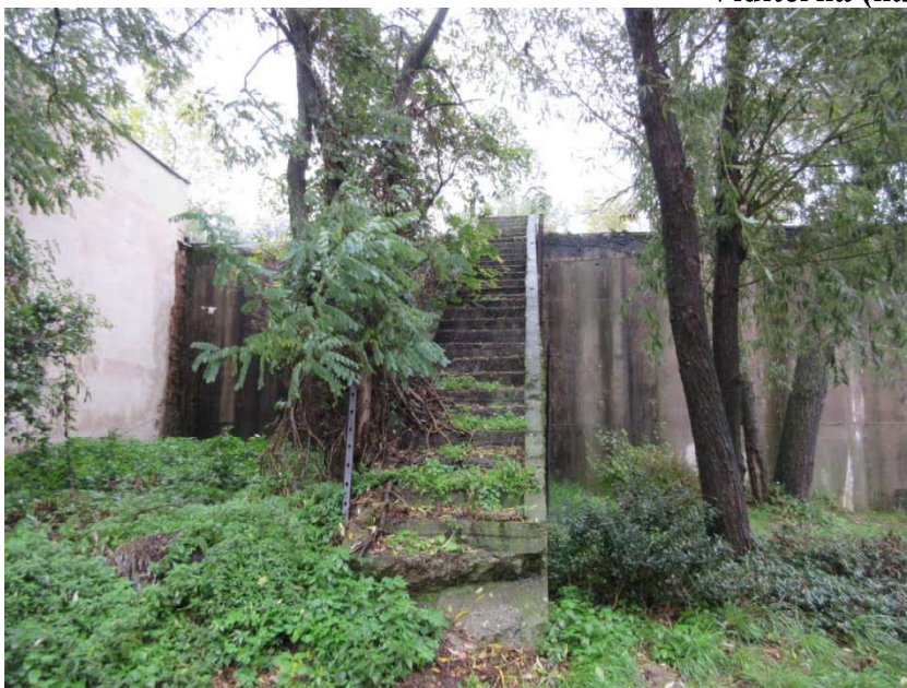
Viditeľná (nadzemná) časť vodojemu
