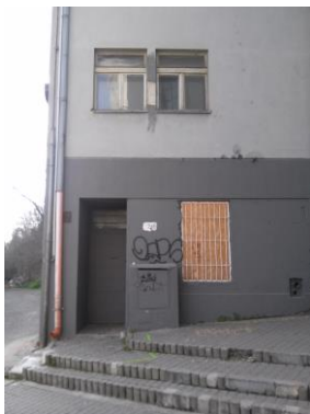
Vstup do objektu
