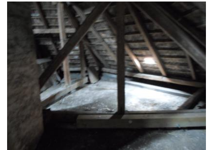
Zastrešenie, krovová konštrukcia
