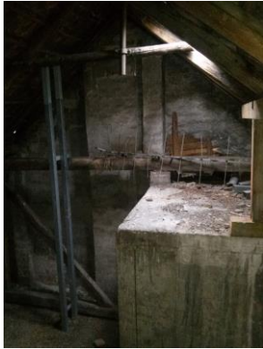
Pohľad zo stropu nad bytom
