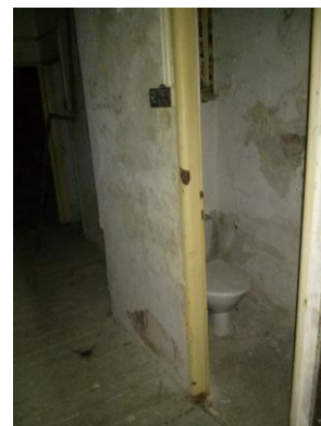
WC z chodby
