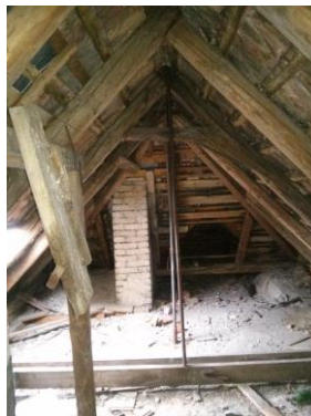
Zastrešenie, krovová konštrukcia
