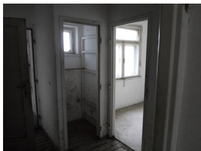
Chodba, pohľad od izby
