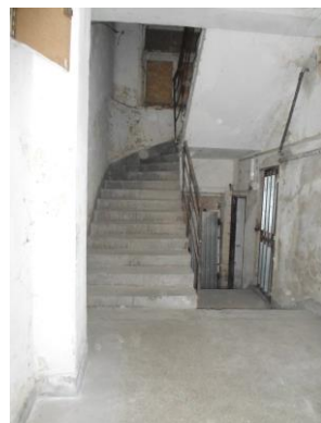
Chodba od vstupných dverí
