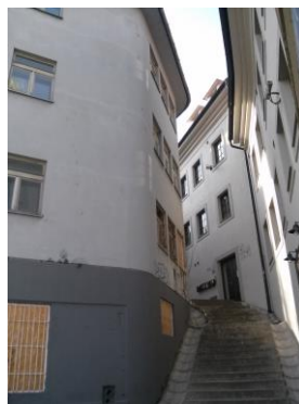
Severná fasáda pri Zámockých schodoch
