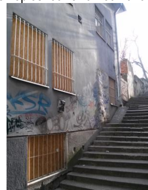
SSZ fasáda pri Zámockých schodoch
