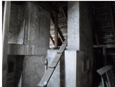
Krov a komínové telesá
