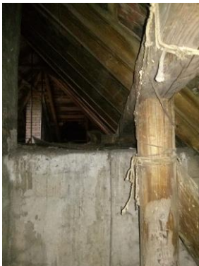
Zastrešenie, krovová konštrukcia
