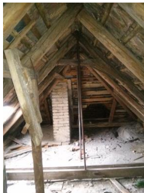
Zastrešenie, krovová konštrukcia
