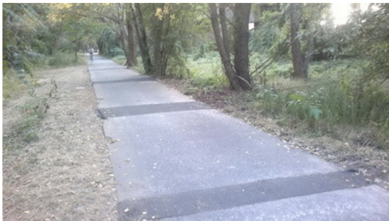
Obnova poškodených úsekov pri Prístavnom moste
