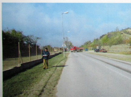
ÚSEK TRASY Č. 2 PRED KAMEŇOLOMOM: ŤAŽKÁ TECHNIKA PREVÁŽA CEZ CESTU HOTOVÝ PRODUKT - TRIEDENÝ LOMOVÝ KAMEŇ
