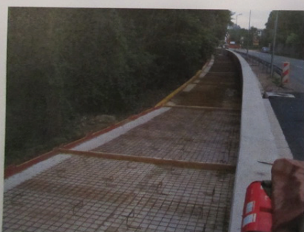
Z VÝSTAVBY 1.ÚSEKU TRASY: ARMOVANIE VRCHNEJ KONŠTRUKCIE KONZOLY
