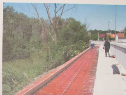
Z VÝSTAVBY 1.ÚSEKU TRASY: ARMOVANIE SPODNEJ KONŠTRUKCIE KONZOLY
