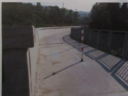
Z VÝSTAVBY 1.ÚSEKU TRASY: DOKONČENÁ CYKLOTRASA - ZAČIATOK ÚSEKU V DEVINE
