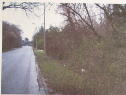
ÚSEK TRASY Č. 4 SÚBEŽNE S OSTROVOM SIHOŤ: ZAČIATOK ÚSEKU Č. 4 A KONIEC ÚSEKU Č. 3
