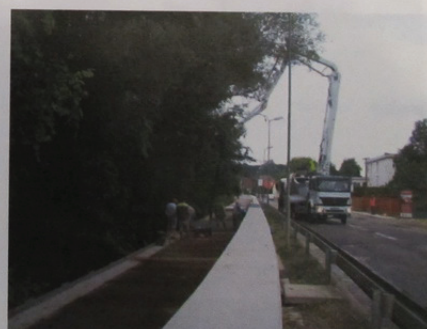
Z VÝSTAVBY 1.ÚSEKU TRASY: ARMOVANIE A BETONÁŽ VRCHNEJ KONŠTRUKCIE KONZOLY
