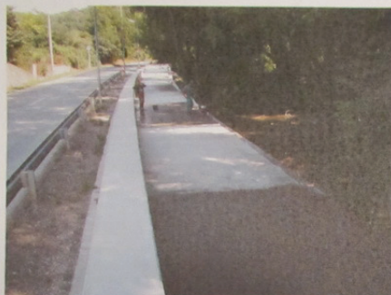
Z VÝSTAVBY 1.ÚSEKU TRASY: VYHLADENIE POVRCHU BETONU
