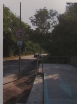
Z VÝSTAVBY 1.ÚSEKU TRASY: DOKONČENÁ CYKLOTRASA - KONIEC ÚSEKU (km 0,300)
