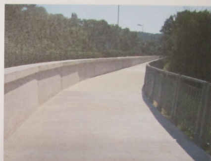
Z VÝSTAVBY 1.ÚSEKU TRASY: ČASŤ HOTOVÉHO ÚSEKU (km 0,050)
