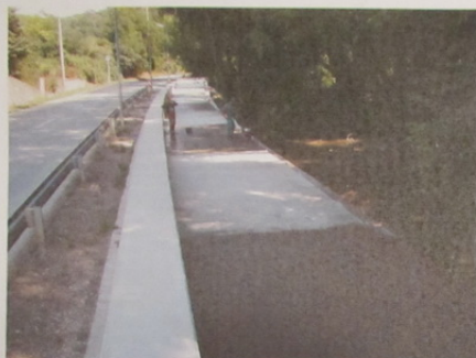
Z VÝSTAVBY 1.ÚSEKU TRASY: VYHLADENIE POVRCHU BETÓNU
