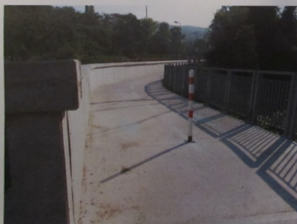
Z VÝSTAVBY 1.ÚSEKU TRASY: DOKONČENÁ CYKLOTRASA - ZAČIATOK ÚSEKU V DEVÍNE
