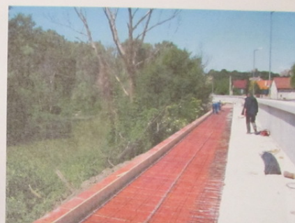
Z VÝSTAVBY 1.ÚSEKU TRASY: ARMOVANIE SPODNEJ KONŠTRUKCIE KONZOLY
