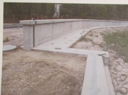
Z VÝSTAVBY 1.ÚSEKU TRASY: ZAČIATOK ÚSEKU V DEVINE
