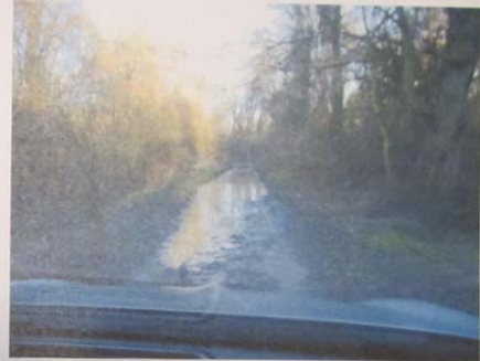
OSTROV SIHOŤ: CESTY SÚ AJ PO BEŽNOM DAŽDI ZALIEATE VODOU, LEBO NIE SÚ SPADOVANÉ ANI ODDRENÁŽOVANÉ
