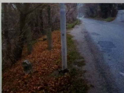
ÚSEK TRASY Č. 5 SÚBEŽNE S OSTROVOM SIHOŤ: POZOSTATKY CESTNÝCH PRVKOV A ZÁKLADOV ELEKTR. STOŽIAŔOV STAREJ CESTY
