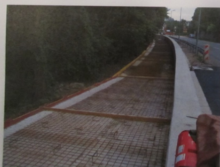
Z VÝSTAVBY 1.ÚSEKU TRASY: ARMOVANIE VRCHNEJ KONŠTRUKCIE KONZOLY
