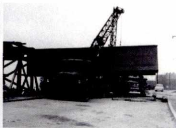
Práce pri budovaní dielni a podzemného vodojemu
