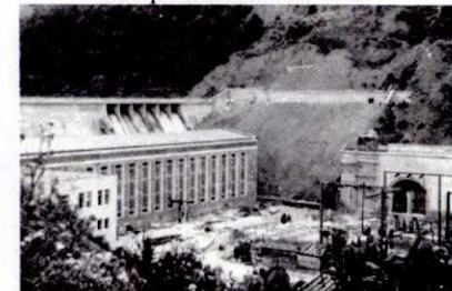
Stav po ukončení v r. 1953
