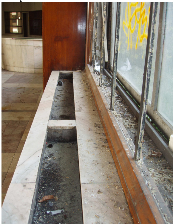
Vstupná sála, rohový barový pult a zavlhnutie šatní (zemná vlhkosť)
