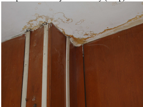
Vstupná sála – záujmové krúžky (strop)
