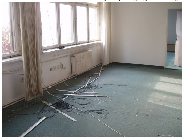
Administratívna časť vstupnej sály (priestory po BKIS)
