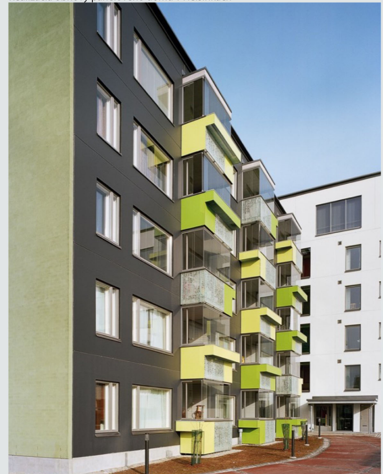
Realizácia obnovy panelového domu v Helsinkách
