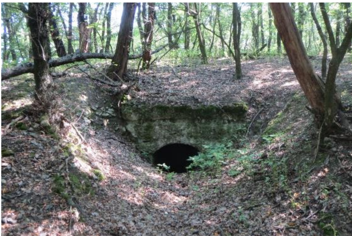
Typický detail vstupu do zasypanej kaverny v Karlovej Vsi na Sitine
