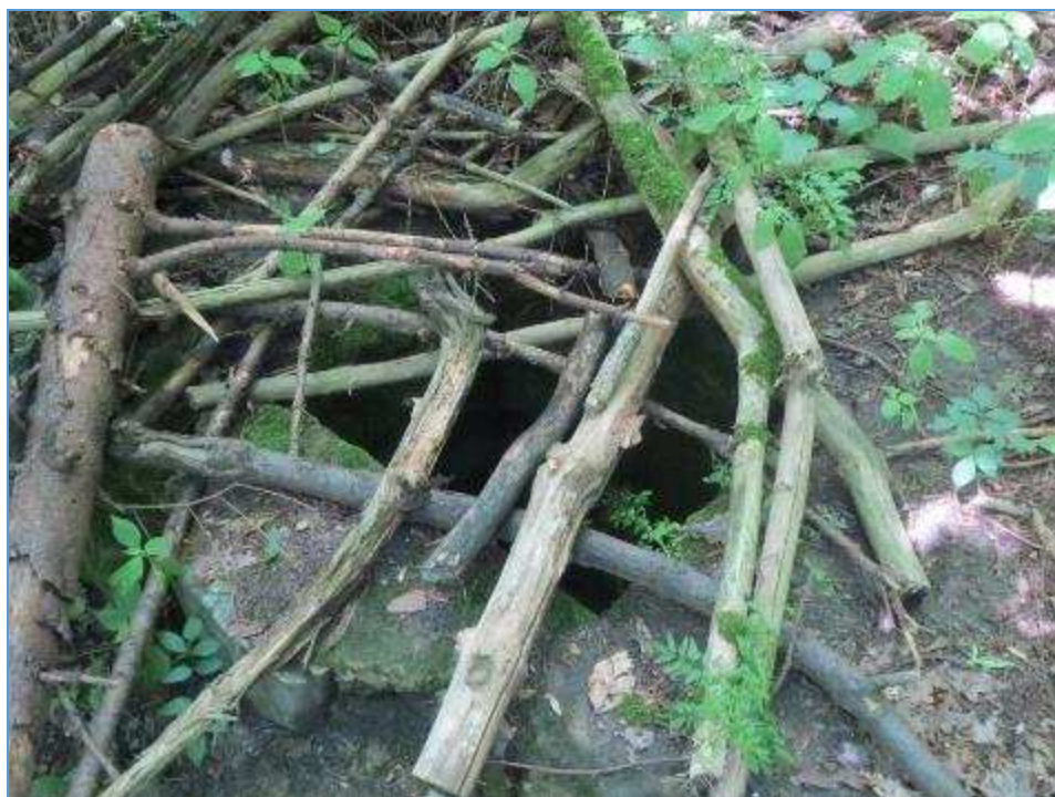
Detail núdzového výlezu malej zasypanej kaverny č.18 na Kamzíku.
