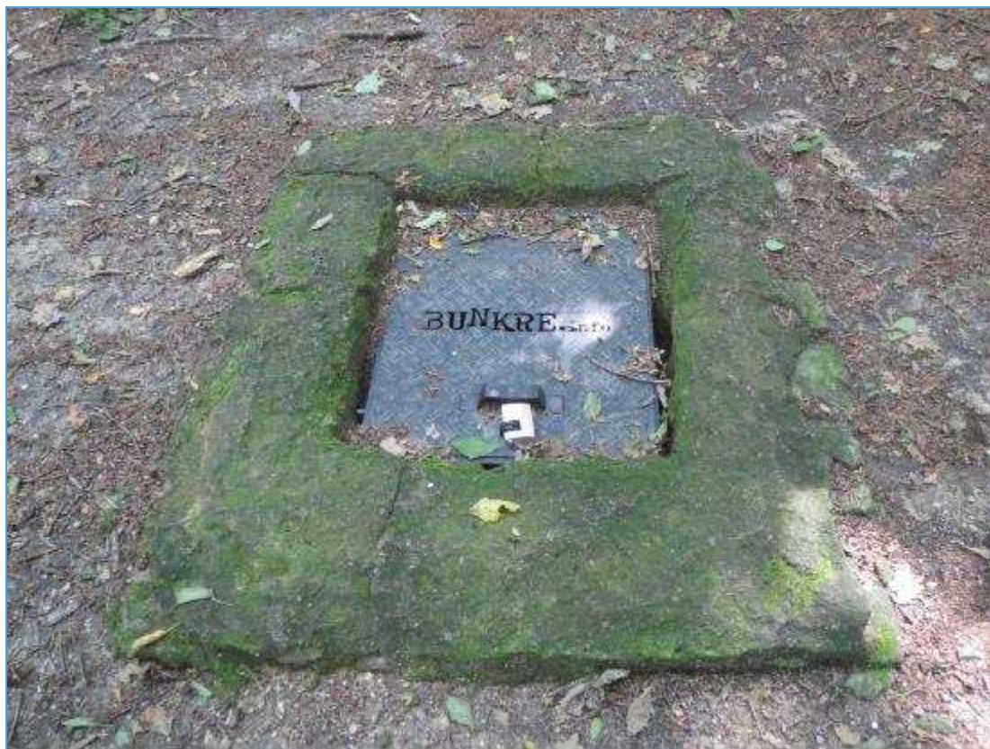
Detail núdzového výlezu obnovenej najväčšej kaverny 006 na Kamzíku
