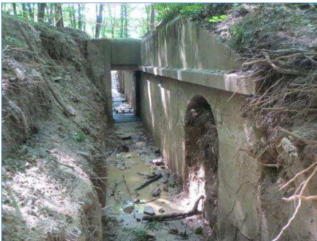
Vyčistený vstup do největší kaverny č.1 v lokalitě Železná studnička – Klepáč.
