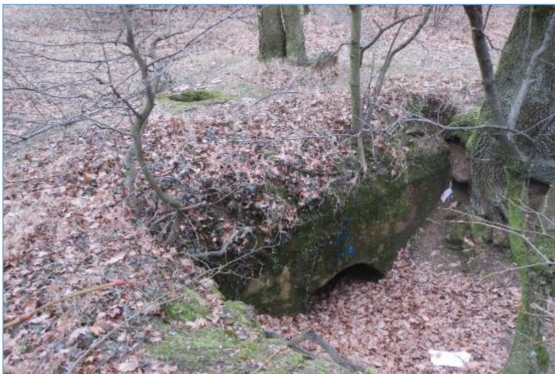
Vstup do zsypanej kaverny č.01 na Dlhých dieloch, v pozadí núdzový výstup.
