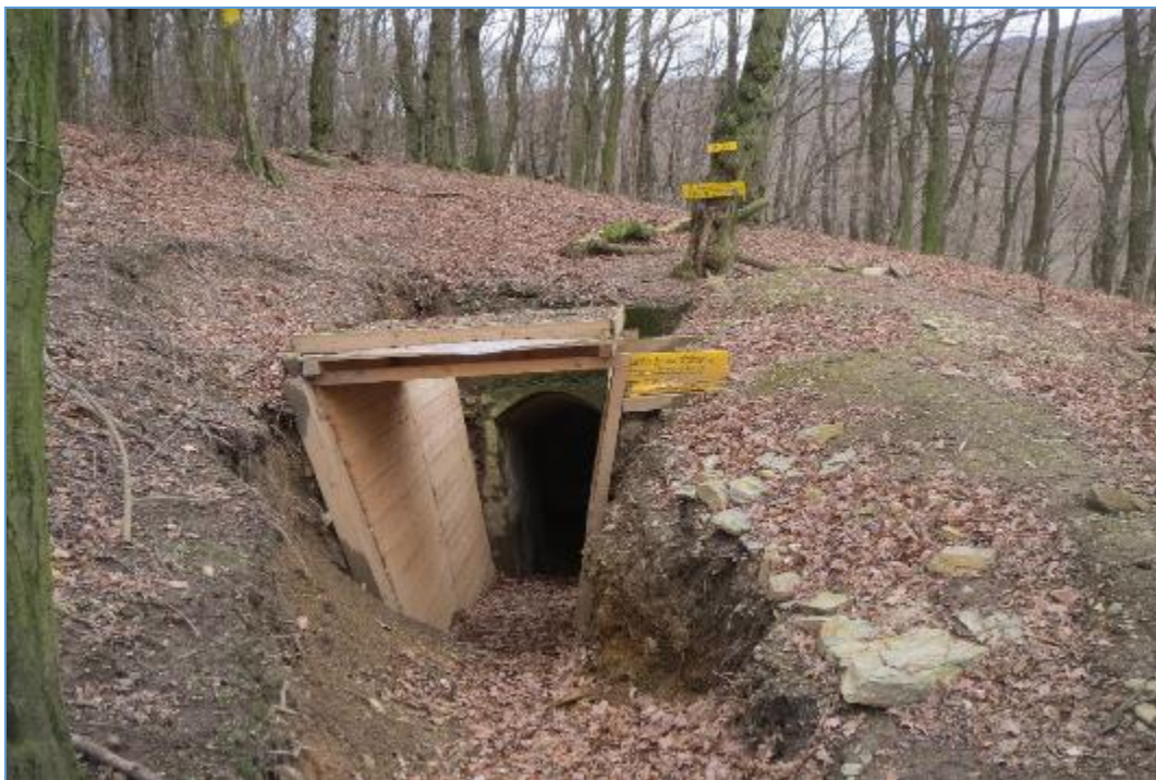
Kaverna č.4 v Dúbravke – vstup s novodobou výdrevou.
