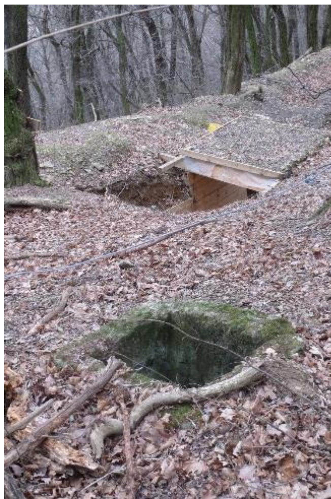
Kaverna č.4 v Dúbravke – detail núdzového východu.
