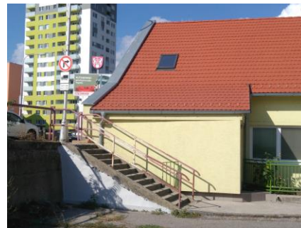
Juhozápadná strana pozemku za schodiskom
